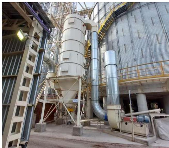
Imagen 25 – Sistema de filtro para la retención de material particulado del sector de descarga. Fotografía tomada el 30/07/2024.
