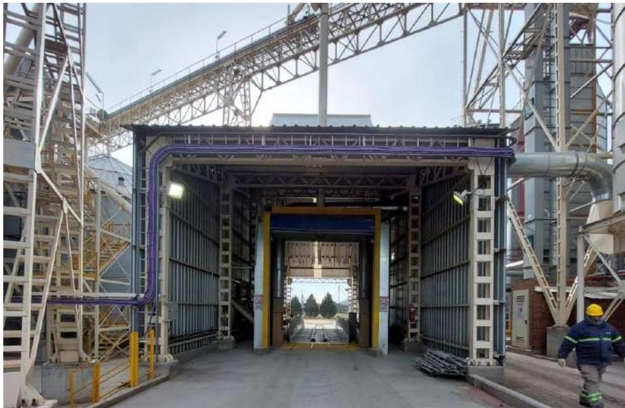
*Imagen 10 - Sector de descarga de granos mediante plataforma volcadora. Fotografía tomada el 30/07/2024.
