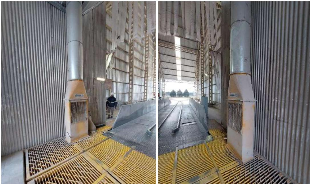
Imagen 24 - Sistema de aspiración de material particulado en descarga de granos. Fotografía tomada el 30/07/2024.
