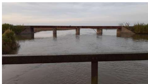
Puente Ferroviario Irala-Coliqueo
