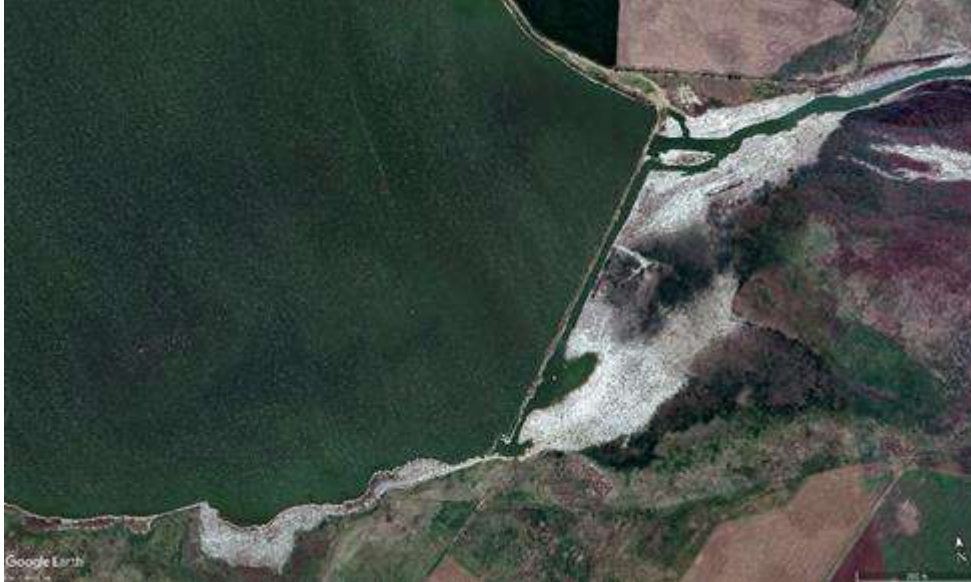
Figura 8: Imagen satelital del terraplén de cierre y brecha en sector suroeste de la Laguna de Rocha - Google Earth. Fte. Dpto. Proyectos de Terceros-DPH.2024
