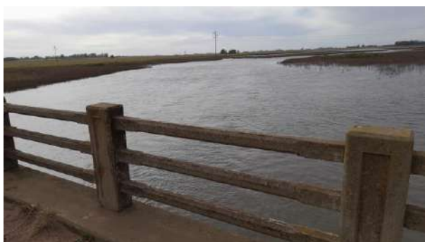
Puente Ruta Nº 42
