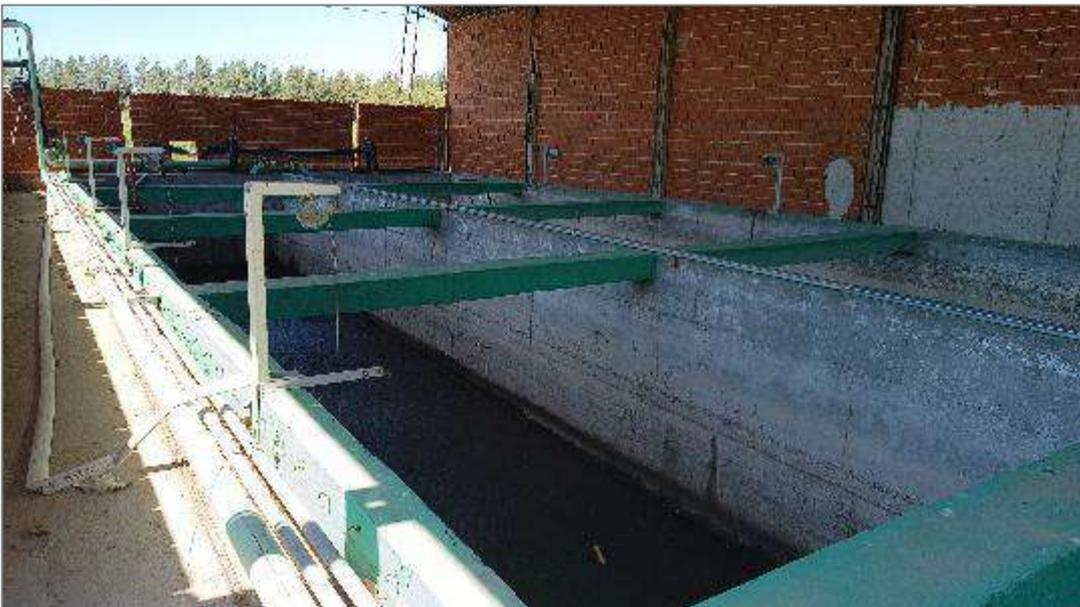
*Figura: Vista de la pileta de recepción del digerido.*
