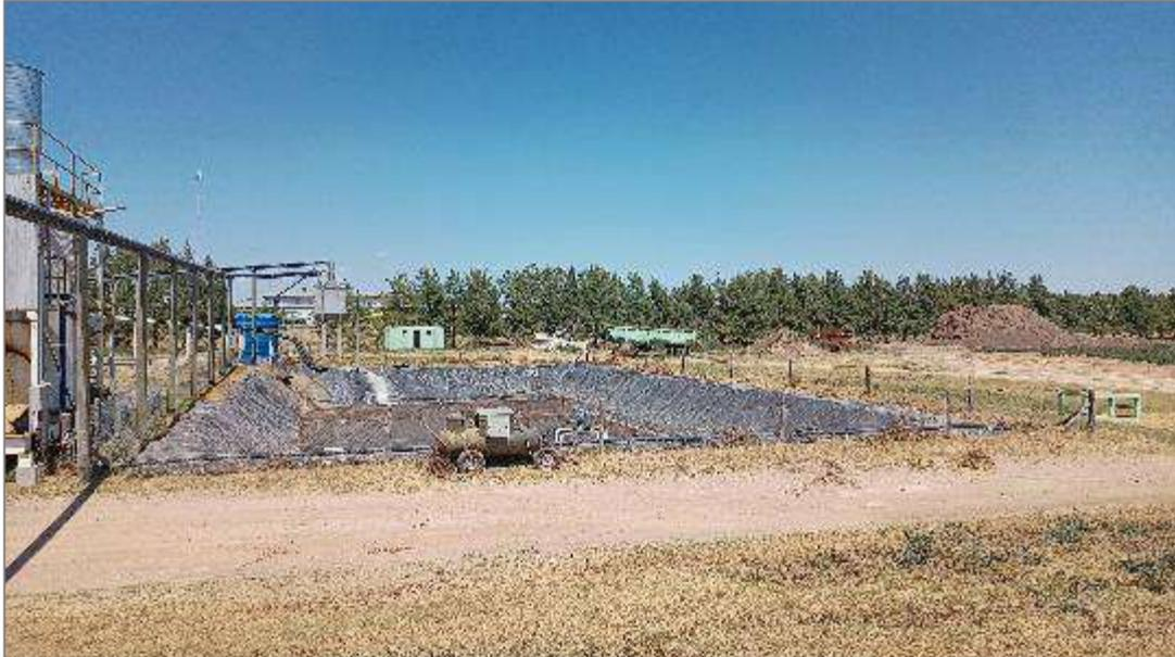
*Figura: Vista de la pileta de recepción del digestato líquido proveniente de la planta de biogás.*
