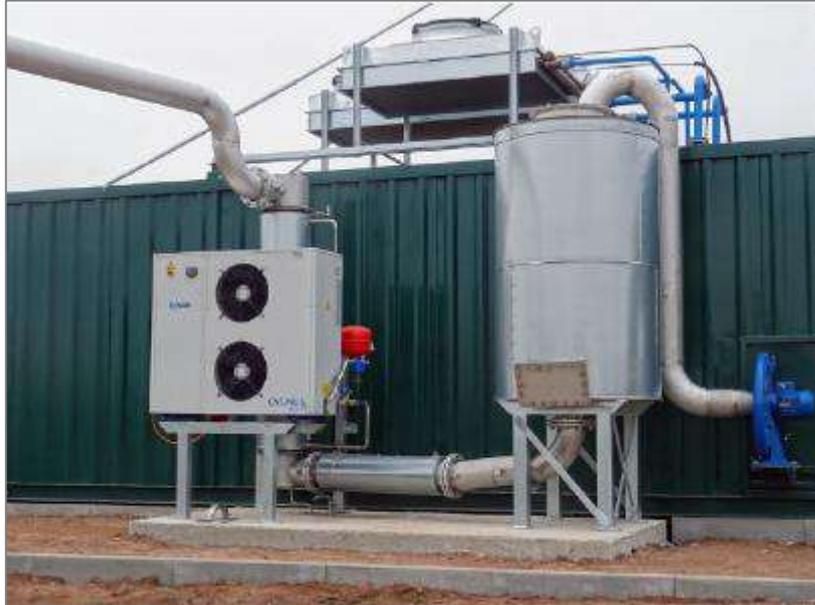
*Figura: Imagen ilustrativa del filtro de carbón activado.*
