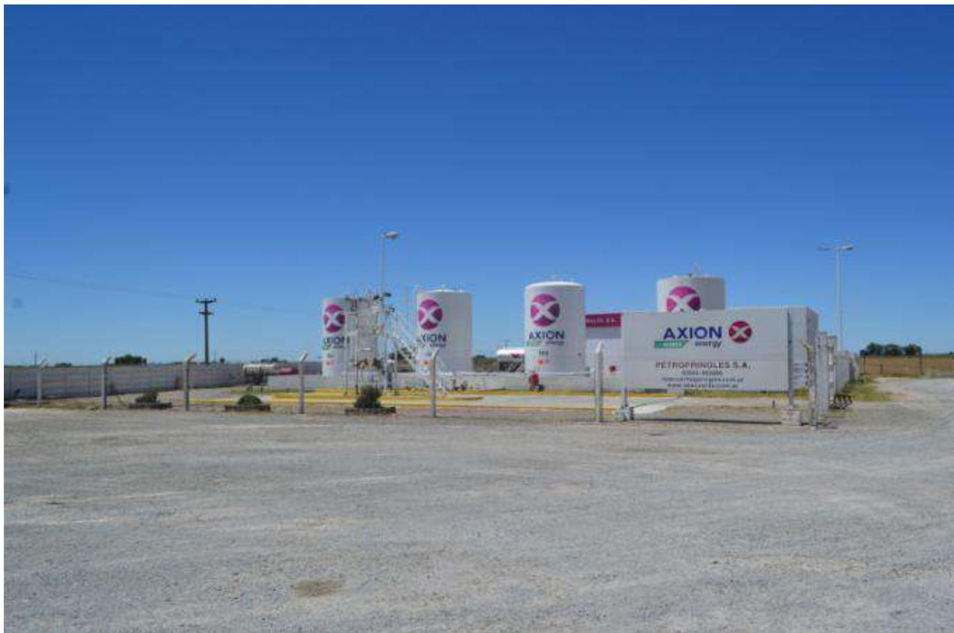
Foto 3.106. Vista en detalle del recinto de tanques de Axion Energy Agro. El sector se encuentra señalizado, delimitado con alambrado perimetral y alumbrado. Se verifica que los tanques se encuentran dentro de muro de contención de derrames.
