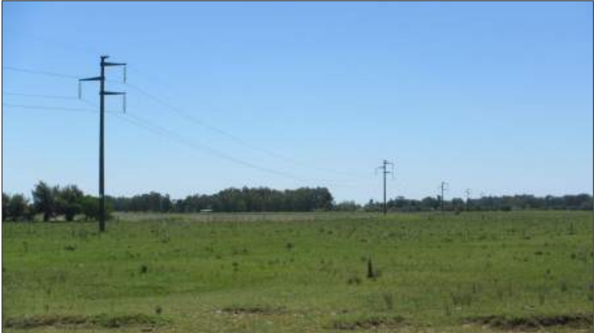
Foto 39. P2 (36.342355 S, 57.686683 W). LAT Alternativas 1, 2 y 3. Vista hacia la ET Dolores a campo traviesa.
