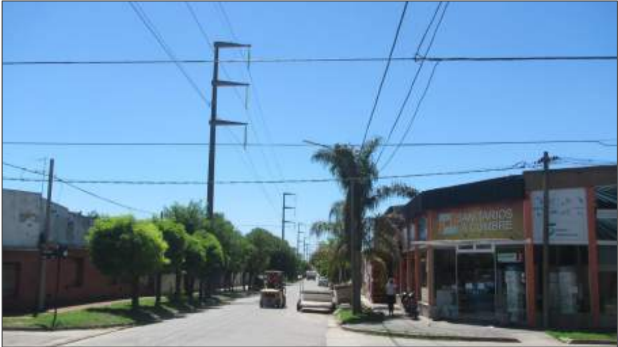
Foto 9. P14 (36.322547 S, 57.676485 W). LAT Actual (roja). Vista desde Sucre y Rivadavia hacia la ruta 63. La traza transcurre por calle Sucre. Zona poblada.
