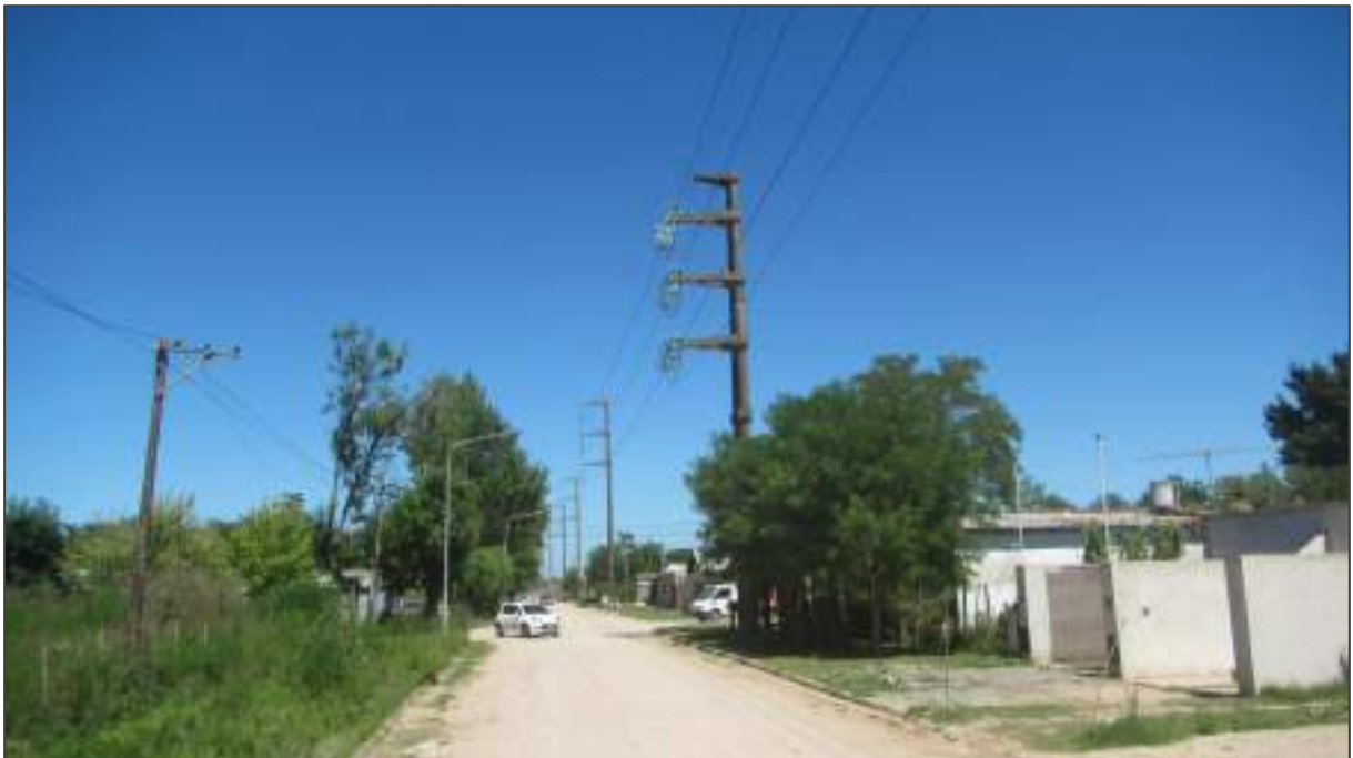
Foto 6. P13 (36.324520 S, 57.681912 W). LAT Actual (roja). Vista desde Sucre y Pilotto hacia la ET Dolores. La traza transcorre por calle Sucre. Zona poblada.
