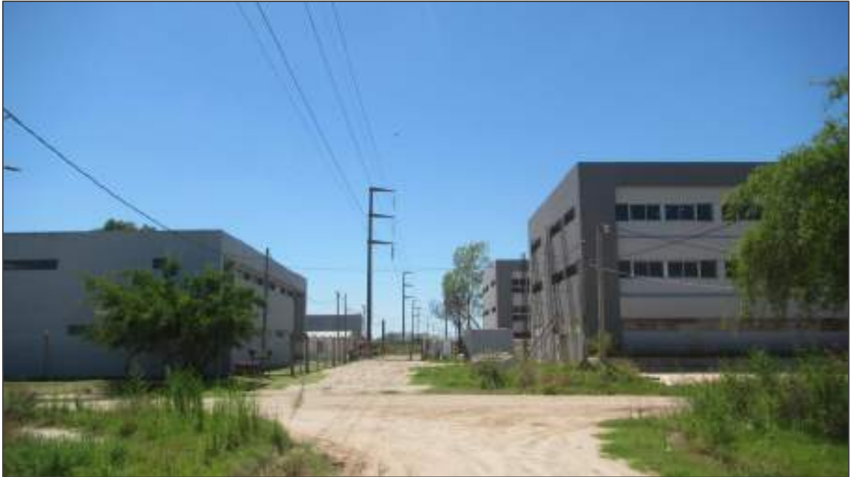
Foto 13. P16 (36.31905 S, 57.66637 W). LAT Actual (roja). Vista desde Kennedy y Robles hacia la ruta 63. La traza transcurre por calle Kennedy. Edificios de la nueva Ciudad Judicial.
