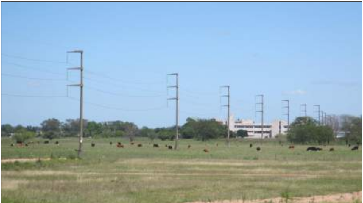
Foto 14. P17 (36.314474 S, 57.652555 W). LAT Actual (roja). Vista hacia la ET Dolores a campo traviesa. Zona despoblada.
