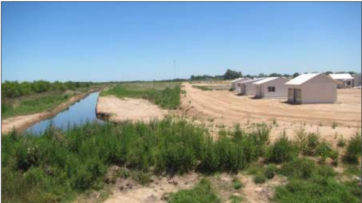
Foto 28. P7 (36.338173 S, 57.65988 W). LAT Alternativa 3 (amarilla). Vista hacia la Ruta 2 (Oeste). A campo traviesa. Interferencia con nuevo barrio de viviendas.
