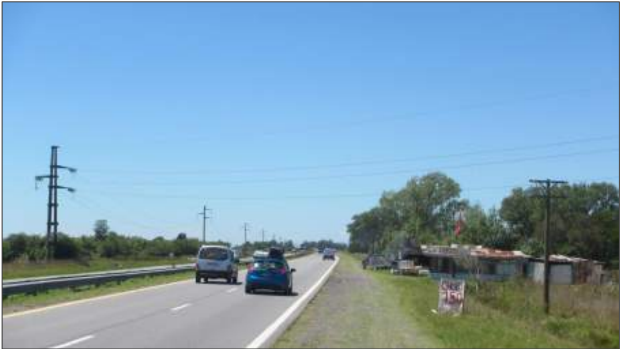
Foto 21. P19 (36.306527 S, 57.631501 W). LAT Actual (roja). Cruce de Ruta 63. Alto tránsito vehicular.
