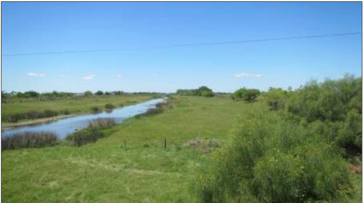
Foto 36. P6 (36.345877 S, 57.671609 W). LAT Alternativa 1(celeste). Vista hacia la Ruta 63 (este). A campo atraviesa por zona de servicio del Canal A.
