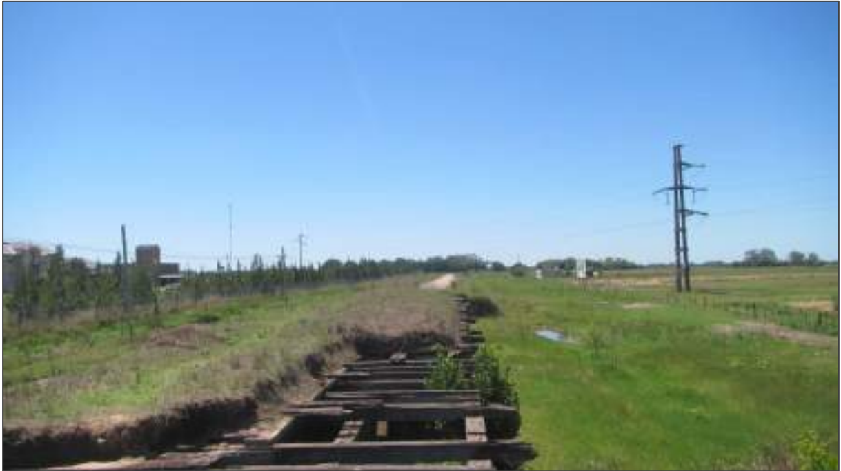
Foto 15. P17 (36.314474 S, 57.652555 W). LAT Actual (roja). Vista hacia LA RUTA 63 A Campo Traviesa. La LAT pasa por el PARQUE TERMAL DE DOLORES.
