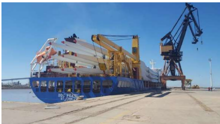
Imagen 29. Vista palas sobre barco en el puerto de Ing. White destinadas a Parque Eólico Corti (Pampa Energía SA). Fuente: La Nueva.com.
