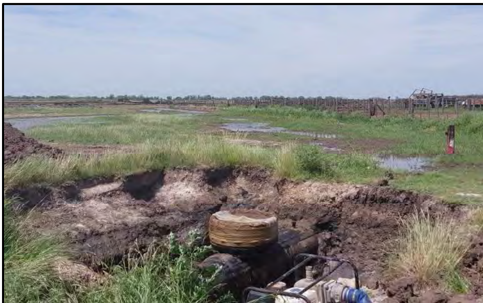
Ilustración 1-6. Progresiva 392, remediación en curso y vista del ducto
