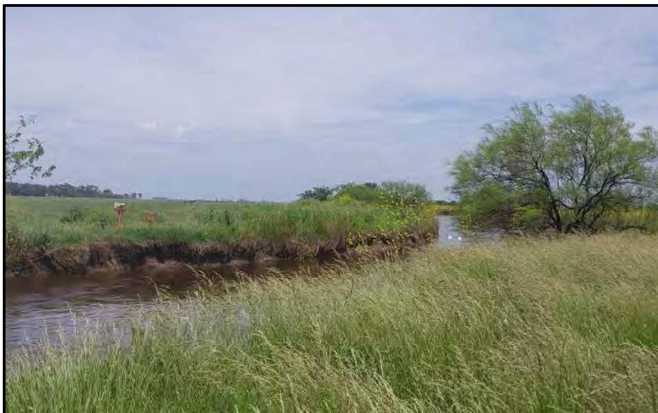
Ilustración 1-12. Progresiva 390, cruce arroyo por PHD vista arroyo desde el norte
