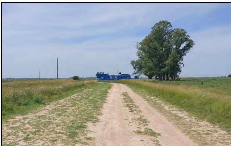
Ilustración 1-22. Progresiva 381, Inicio Tie In vista hacia escuela
