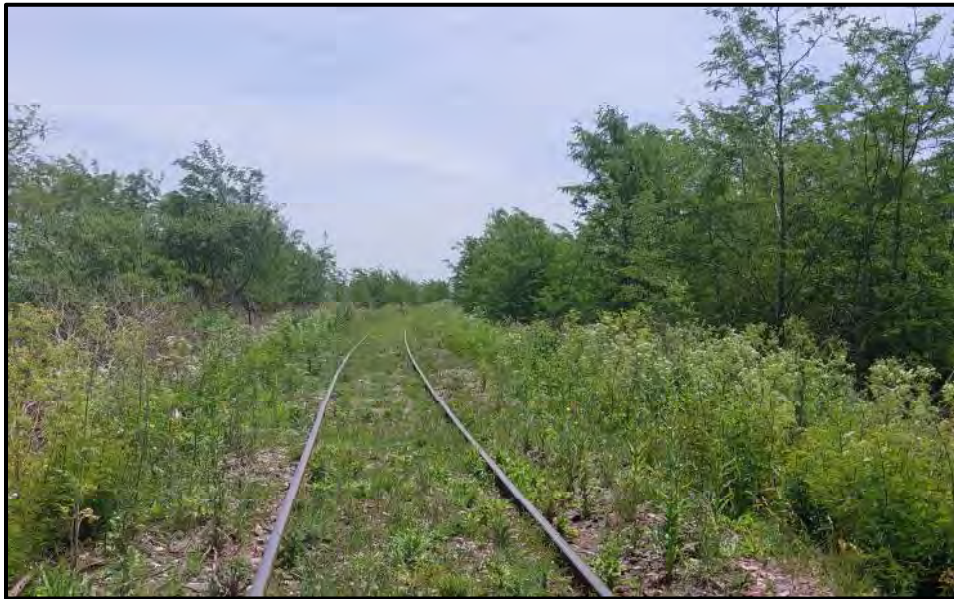
Ilustración 1-9. Progresiva 390, cruce ferrocarril por PHD vista vías
