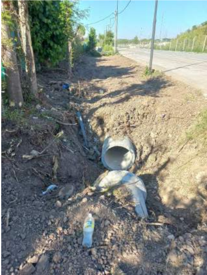
Figura 4. Vista de perfiles con sedimentos removidos.
