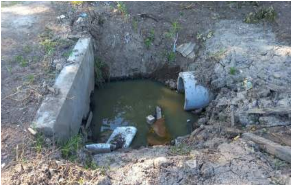
Figura 6. Relleno de los canales excavados con los sedimentos retirados de la misma excavación.
