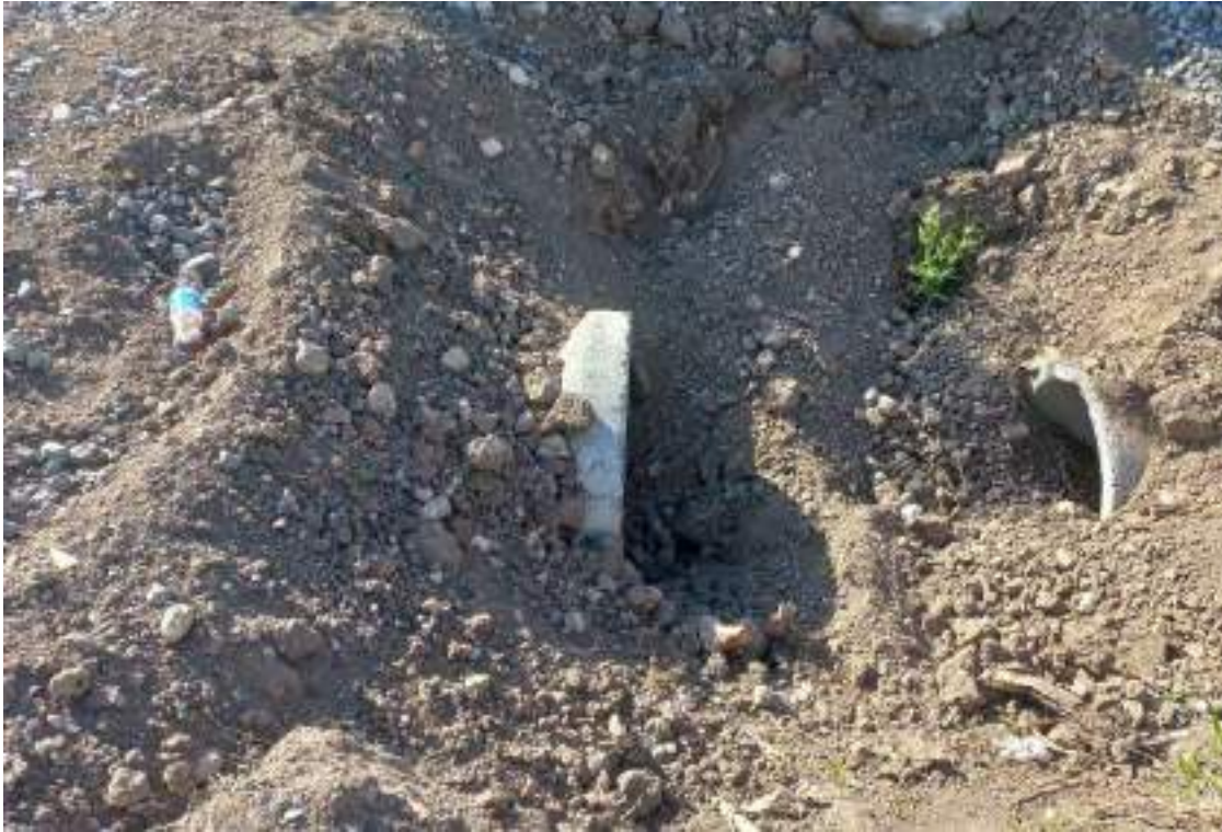
Figura 5. Relleno de los canales excavados con los sedimentos retirados de la misma excavación.
