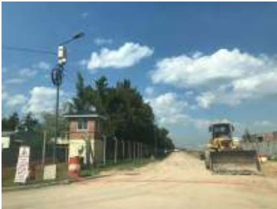
Foto 19: C. Barbarita desde Marcos Paz hacia Av. Nordelta. Calle en obra
