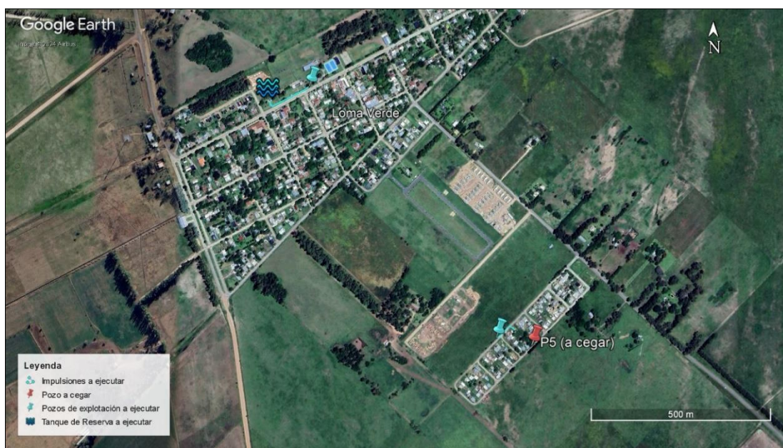
Figura 1: Ubicación de las obras proyectadas.
