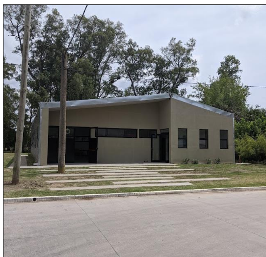
Figura 83: Salón de Usos Múltiples Municipal.
