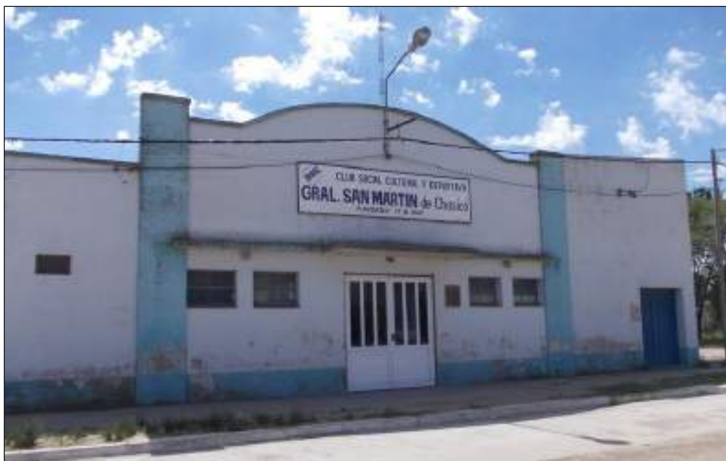
Figura 44: Fachada del club San Martín en Chasicó.
