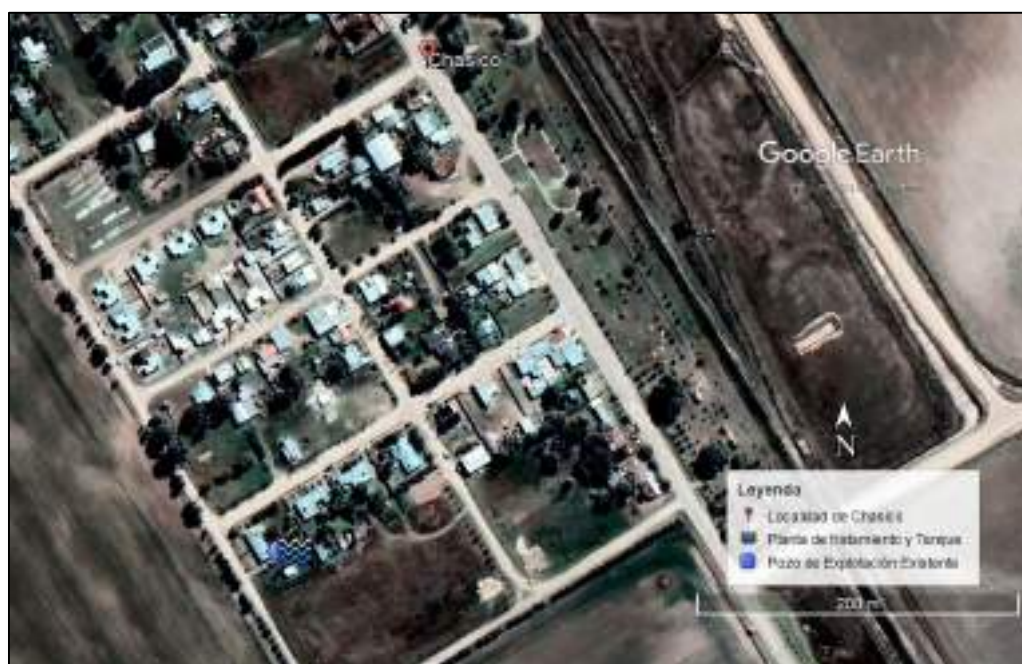
Figura 2: Ubicación del pozo existente, la planta de tratamiento y el tanque de almacenamiento.
