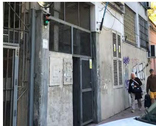
Foto 10: Telecom - Av. Libertador San Martín 163.
