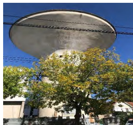
Foto 18: Tanque AySA - Madero 420.
