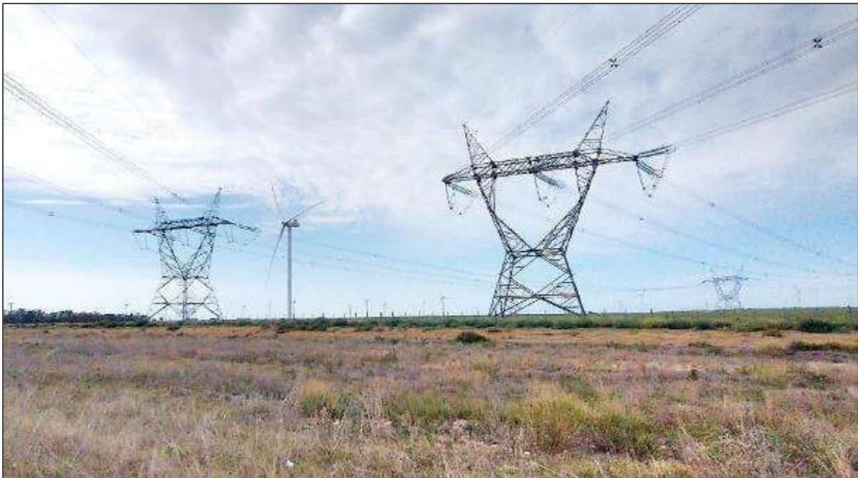
Foto 20. S7 (38.657983°S, 62.045884°W) RP51 sector cruce de LEAT 500 kV. Vista hacia el ESE. La vinculación de PEPE VI al SADI se realizará a través de la línea 5BBLP2, que se ve del lado izquierdo de la fotografía, a partir de la construcción de un campo de toma en T rígida.
