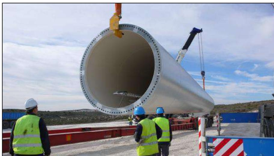
Figura 1.8. Transporte de torres de aerogenerador.
