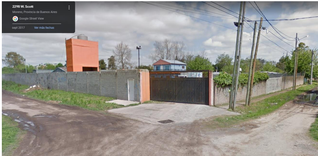
Foto 1: Predio correspondiente a la futura S.E. Moreno
