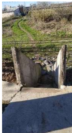
CP IRREGULAR JUNCAL, VISTA HACIA LA
