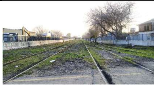
VISTA HACIA EST. SCHWEITZER. SE OBSERVA CERRAMIENTO NEW JERSEY CON ENREJADO METÁLICO.
