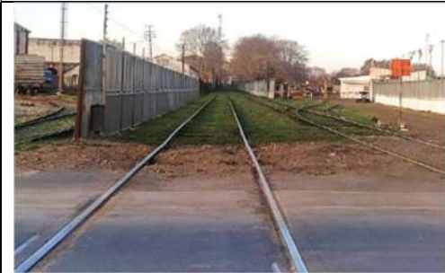
V HACIA EST VICTORIA, A LA IZQ ACCESO TALLERES VICTORIA, A LA DER DEPÓSITO FERROVIARIO
