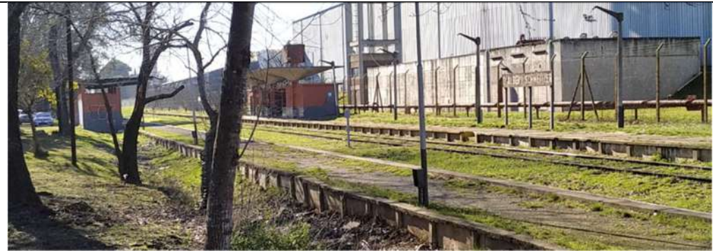
EST. SCHWEITZER, VISTA HACIA EST. VICTORIA DESDE LD. LINDERO A LA SE OBSERVA PLANTA INDUSTRIAL
