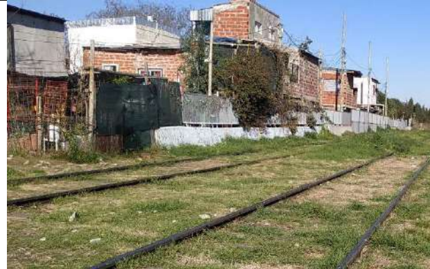
VISTA ACTUAL DE TRAZA INTRUSADA DESDE CP SARGENTO DÍAZ
