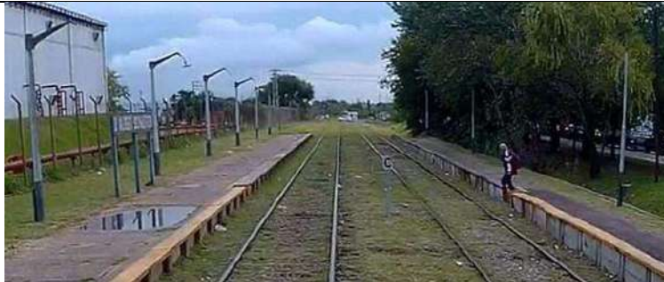
EST. SCHWEITZER, VISTA HACIA EST. EL TALAR. CP ENTRE ANDENES
