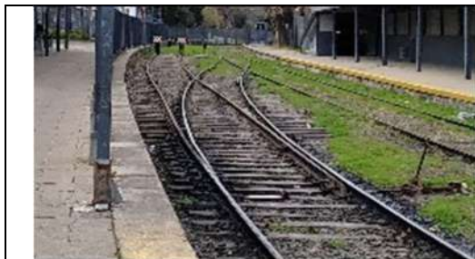
ESTACIÓN VICTORIA, ANDENES DEL RAMAL A CAPILLA DEL SEÑOR, VISTA HACIA RETIRO
