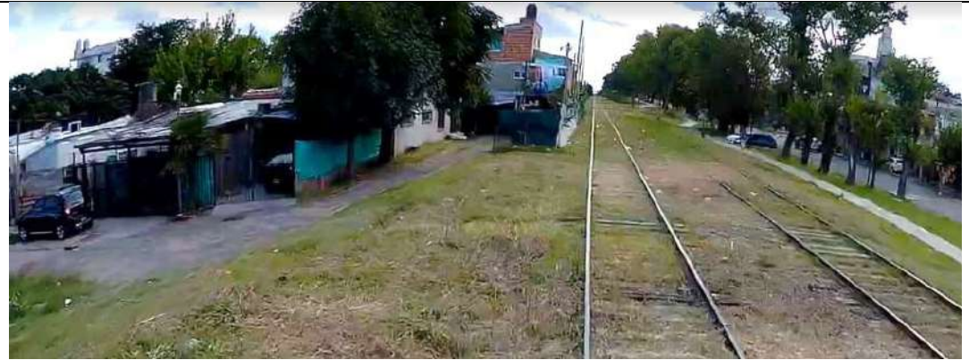
TRAMO DE LA TRAZA INTRUSADO SOBRE LA, DELIMITADA CON CERRAMIENTOS (IMAGEN AÑO 2019).
