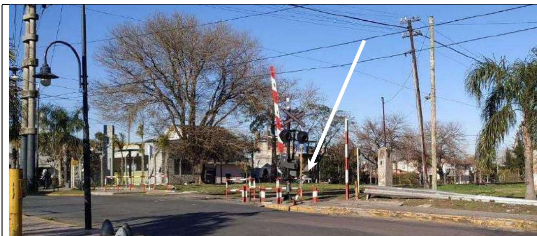
CVP CALLE BLANCO ENCALADA, CON SEÑALIZACIÓN ACTIVA Y PASIVA. VISTA HACIA LA. SE SEÑALA CON UNA FLECHA EL SECTOR DONDE SE LOCALIZARÁ LA SER SCHWEITZER.
