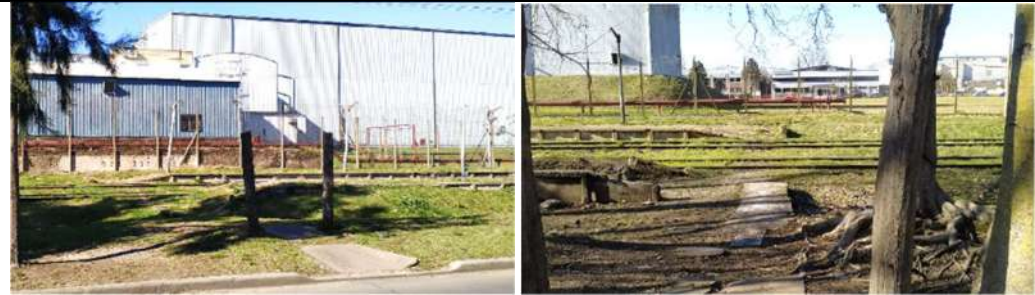
CP IRREGULARES EN AMBOS EXTREMOS DE ESTACIÓN SCHWEITZER
