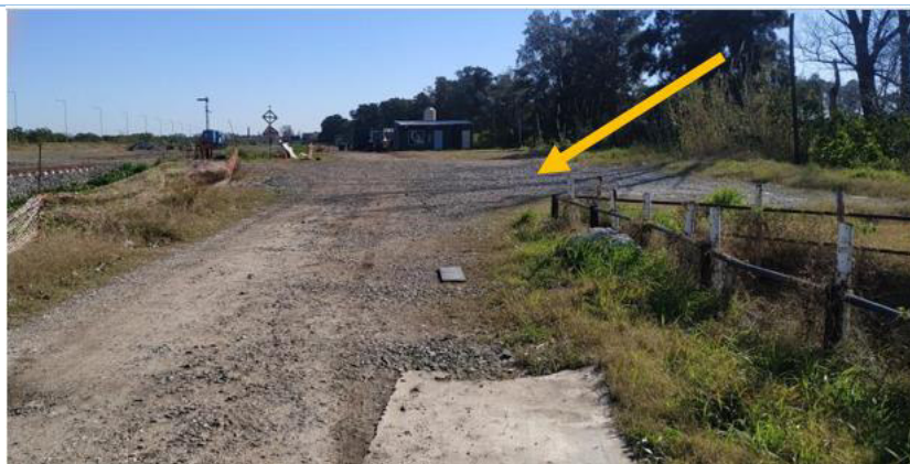
SER Bancalari, vista hacia la estación Bancalari. Se señala con una flecha el sitio de implantación de la subestación
