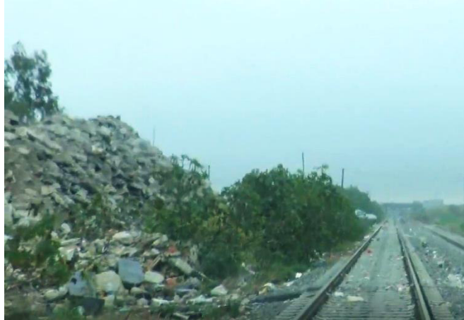
Vista a est. Bancalari. Sobre LA se observan montículos de áridos que invaden la traza, con escombros sobre los durmientes. En la foto de la der, al fondo, vehículo en CVP Andrade
