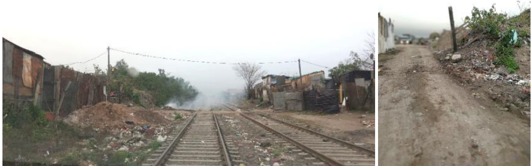
CVP próximo al anterior. Foto izq vista a est. Bancalari, se observa quema de residuos. Foto der vista LA.
