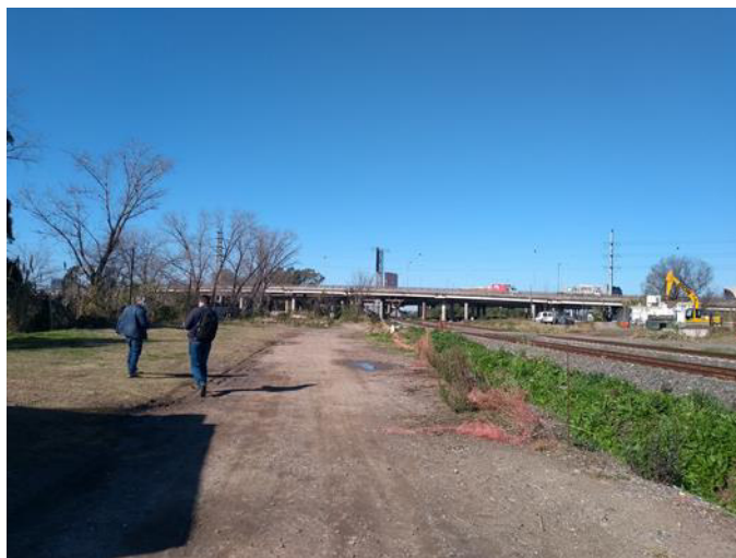
ILUSTRACIÓN 28 - PREDIO EN EL QUE SE CONSTRUIRÁ LA SER BANCALARI.HACIA EL FONDO VIADUCTO RN 9
