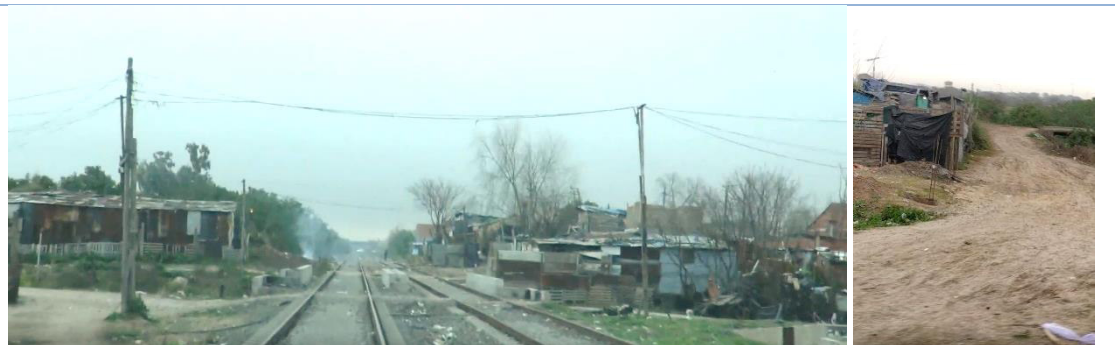
Cruce previo a curso de agua. Foto izq vista a est. Bancalari. Foto der vista LA.
