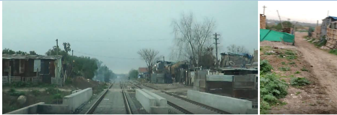
Cruce posterior a curso de agua. Foto izq vista a est. Bancalari. Foto der vista LA.
