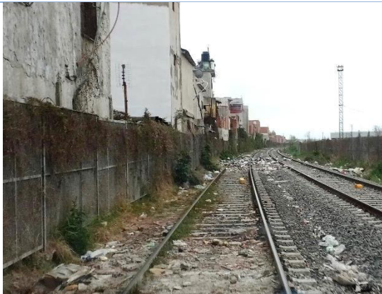
Vista hacia Bancalari. Sector S del barrio Trece de Julio. Abundantes residuos en zona de vías
