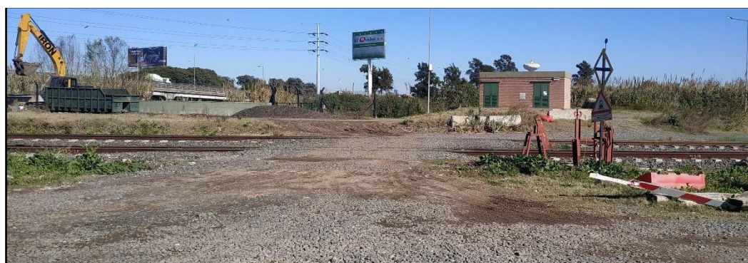
CVP, VISTA HACIA LA. SE OBSERVAN RESTOS DE EQUIPOS DE SEÑALAMIENTO ACTIVO. EN EL CENTRO AL FONDO SE OBSERVA INSTALACIONES CONSTRUIDAS POR SOBRE EL NIVEL DE LA RASANTE FERROVIARIA.
