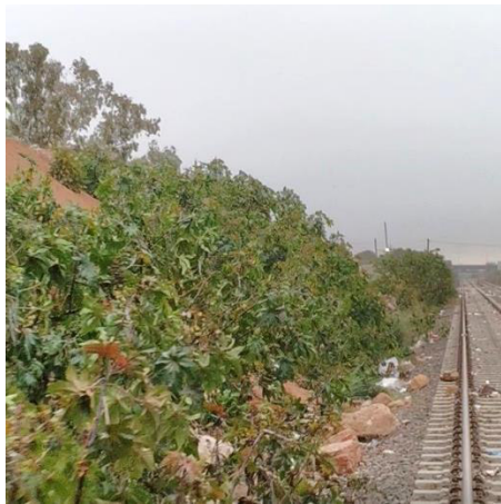
Vista a est. Bancalari. Sobre LA se observan montículos de áridos que invaden la traza, con escombros sobre los durmientes. En la foto de la der, al fondo, vehículo en CVP Andrade
