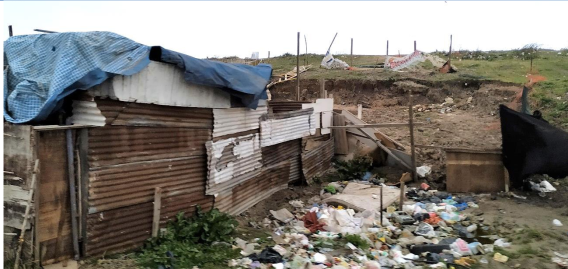
Vista hacia LA. Extremo norte del Barrio Trece de Julio. Se observa excavación en borde de antigua celda de relleno sanitario.
