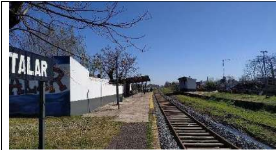
Vista hacia estación Garín, se observa trabajos de renovación de vía ascendente
