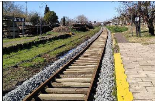
VISTA HACIA EST SCHWEITZER, AL FONDO SE OBSERVA VIADUCTO AVENIDA H YRIGOYEN.
