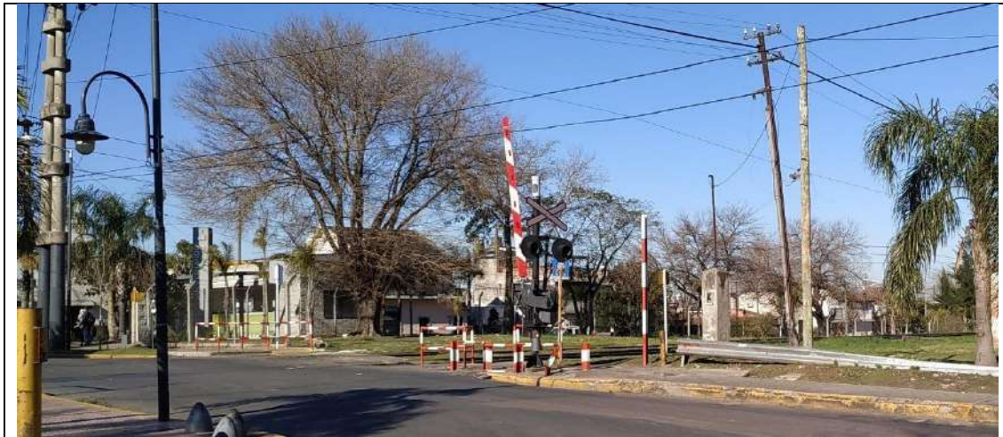
CVP CALLE BLANCO ENCALADA, CON SEÑALIZACIÓN ACTIVA Y PASIVA. VISTA HACIA LA, DONDE SE LOCALIZARÁ LA SER SCHWEITZER
