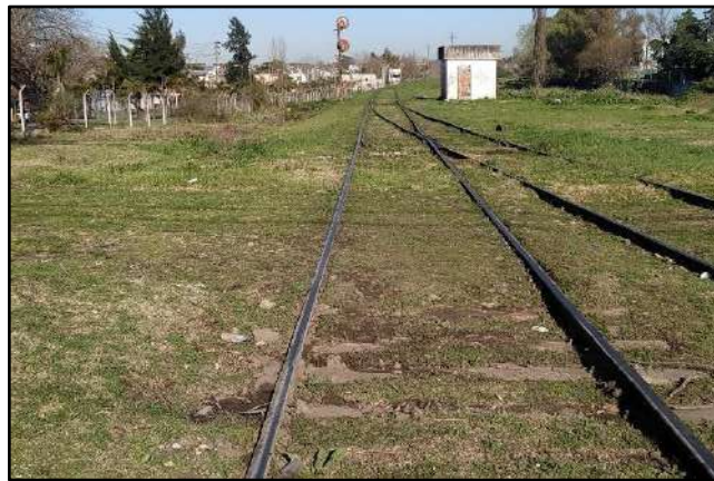
Inicio del tramo, con vía única, vista hacia Estación El Talar.
