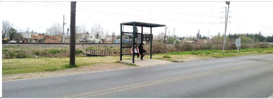
CP BARRIO LAS TUNAS, VISTA HACIA LA DESDE CORREDOR VIAL BANCALARI-BENAVIDEZ. SE OBSERVA PUENTE PEATONAL SOBRE LD
