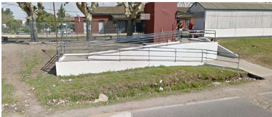
ACCESO A ESTACIÓN BENAVIDEZ LADO DESCENDENTE DESDE CALLE DEÁN FUNES
