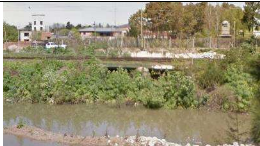
VISTA HACIA LA DE ALCANTARILLA ORIGINAL (IMAGEN DE 09/2014, FUENTE: STREET VIEW)
