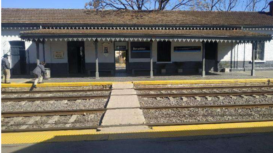
EDIFICIO DE LA ESTACIÓN BENAVIDEZ Y CRUCE PEATONAL, VISTA HACIA LADO ASCENDENTE
