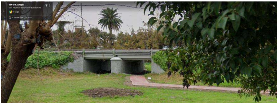
CRUCE BAJO UNA ALCANTARILLA DEL FFCC
