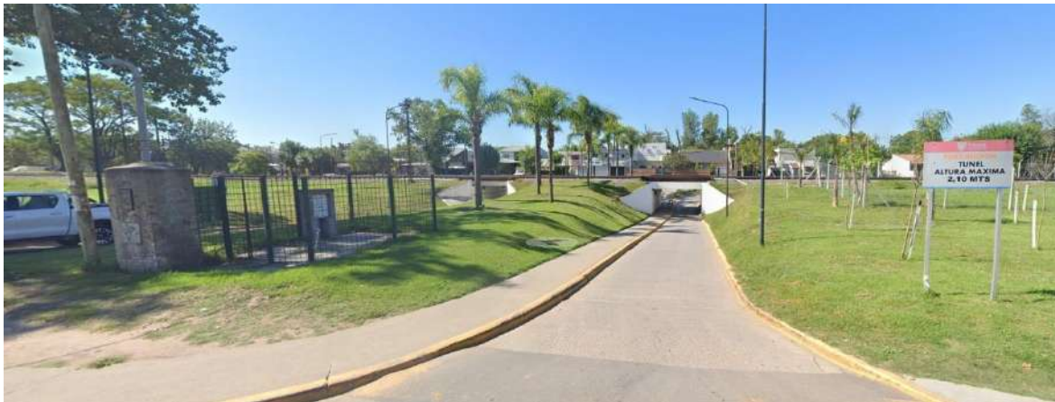
TÚNELES VEHICULARES CALLE MORENO VISTA DESDE LADO ASCENDENTE
