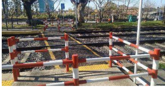
ESTACIÓN PACHECO, VISTA A LD, EXTREMO DE LA ESTACIÓN HACIA BANCALARI. LA SENDA SE CONECTA AL FONDO CON CORREDOR BANCALARI-BENAVIDEZ
