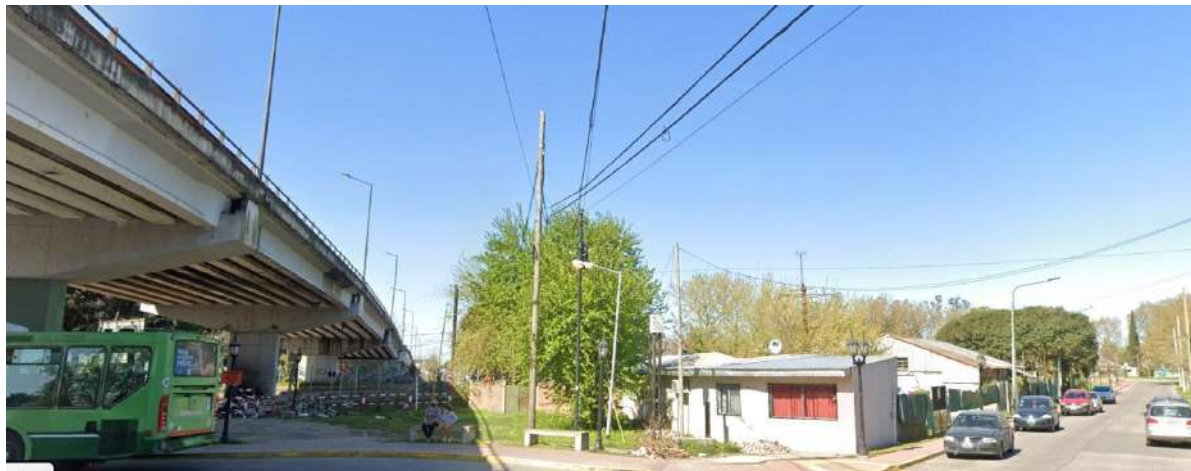
VISTA DESDE LA ESQ DE H YRIGOYEN (RN 197) Y PASAJE PACHECO. A LA IZQ SE OBSERVA EL VIADUCTO DE LA RN 197, A LA DERECHA ACCESO A ESTACIÓN PACHECO POR EL PASAJE
