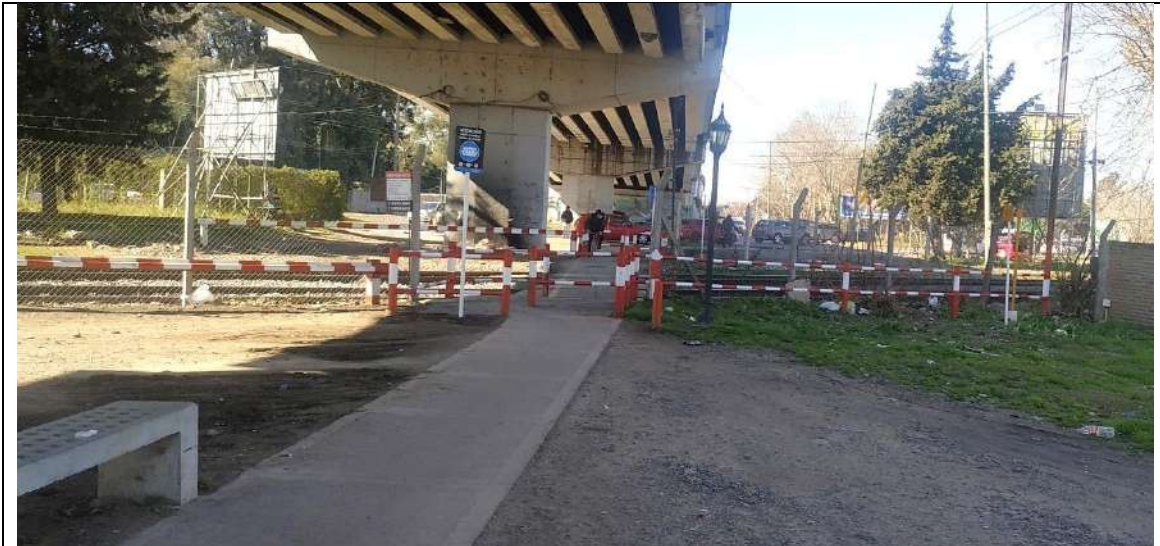
Cruce peatonal av Hipólito Yrigoyen, vista hacia LD.
