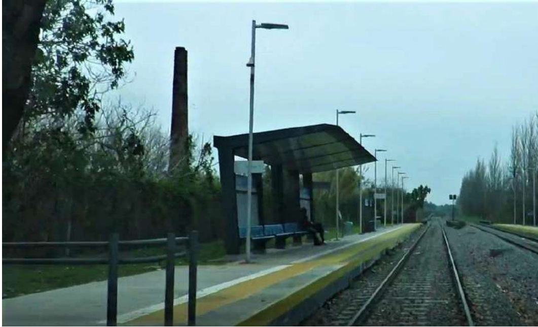
ILUSTRACIÓN 44 -VISTA ACTUAL DE LA CHIMENEA DEL MOLINO HARINERO DESDE LA ESTACIÓN BANCALARI
