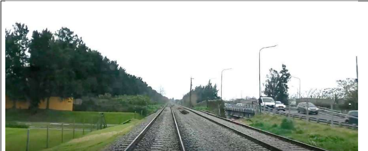
Vista a est Pacheco, a la izq barrio cerrado, a la der Corredor Bancalari-Benavidez. Se observa el cruce bajo nivel de acceso a la urbanización desde el corredor.
