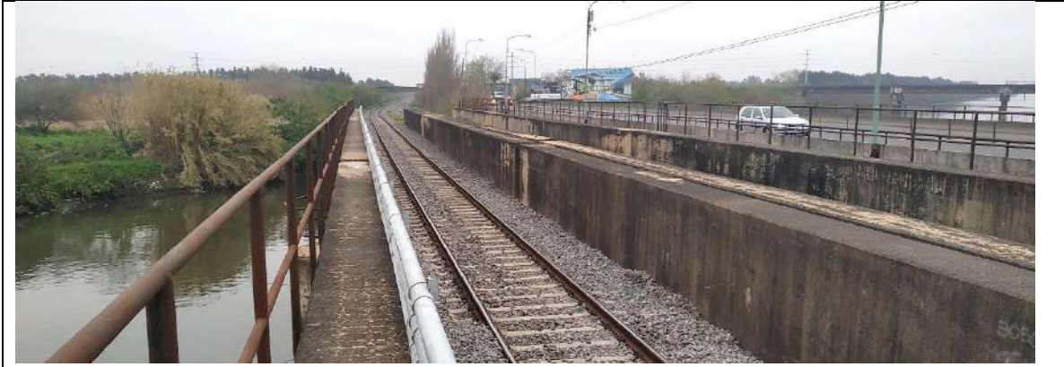
Puente s/ el río Reconquista, vista a est. Pacheco. A la der corredor vial Bancalari-Benavidez. Al fondo se observa el cruce elevado del ramal Victoria-Capilla sobre la traza y el río
