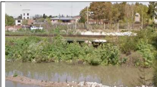
Vista hacia LA de alcantarilla original (imagen de 09/2014, fuente: Street View)
