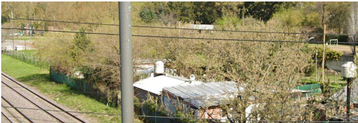
ILUSTRACIÓN 40 - VISTA DEL PREDIO HABITADO DESDE EL VIADUCTO DE LA RN 197
