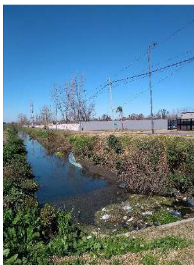
ILUSTRACIÓN 67 -VISTA DEL ZANJÓN EXISTENTE QUE CORRE PARALELO A LA CALLE ARTIGAS
