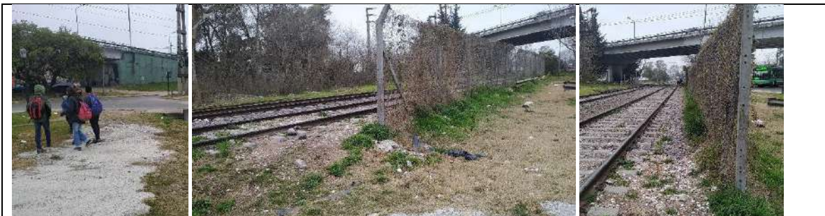
Sector CP Yrigoyen, fotos sobre LA. De izq a der: acceso hormigonado desde la calle, punto de ingreso a zona de vías y sector donde se circula por la traza.
