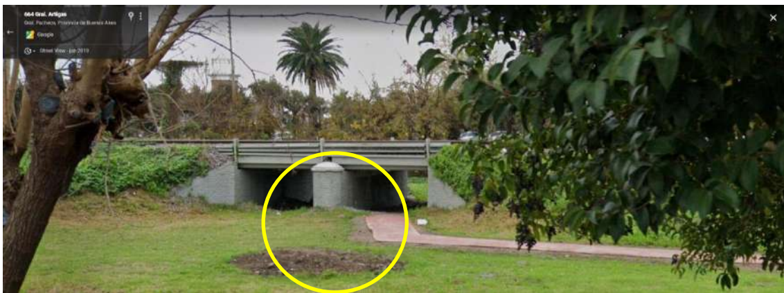
ILUSTRACIÓN 62 –CRUCE PEATONAL A TRAVÉS DE UNA ALCANTARILLA DEL FFCC
