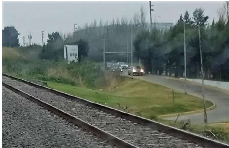
Ilustración 64 – Área De Instalación De La Nueva Ser Pacheco
