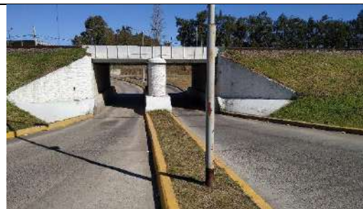
Vista actual de la alcantarilla hacia LA, la SER Pacheco se ubica a la derecha del paso
