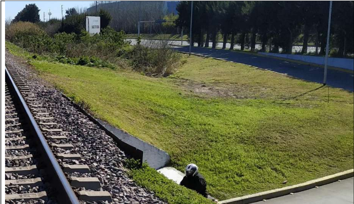
Vista LD. En primer término, cruce vehicular bajo nivel, a la derecha corredor Bancalari-Benavidez
