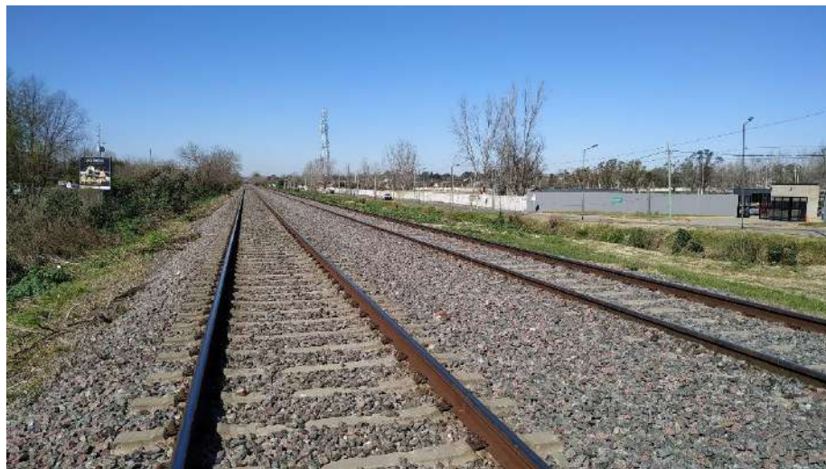
ILUSTRACIÓN 65 - SECTOR DONDE SE EMPLAZARÁ LA NUEVA SER PACHECO SOBRE EL LADO ASCENDENTE (SECTOR DERECHO EN LA FOTO). SOBRE EL MISMO LADO SE APRECIA EL INGRESO VEHICULAR AL CLUB Y COLEGIO HANS ANDERSEN
