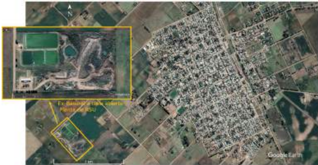
Figura 67: Ubicación de la Planta de Tratamiento de Residuos de Salliqueló ( 36^{\circ}45'36,25''S 62^{\circ}58'53,38''O ).
