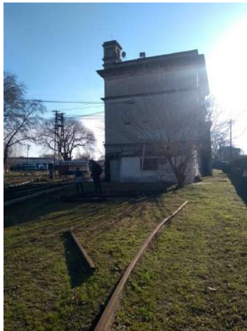
Vista del edificio lindero a la SER en el predio
