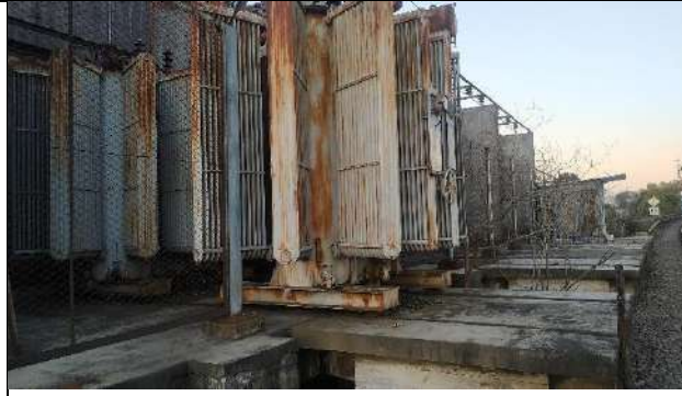
Ilustración 72 - SER Palermo a nivel de las vías. Vista hacia Retiro
