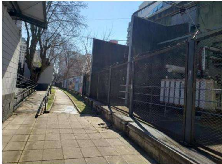
Camino y rampa para acceso al andén calle Corrientes
