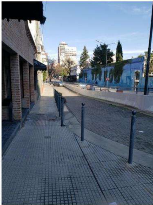
Paso Bajo nivel vehicular
