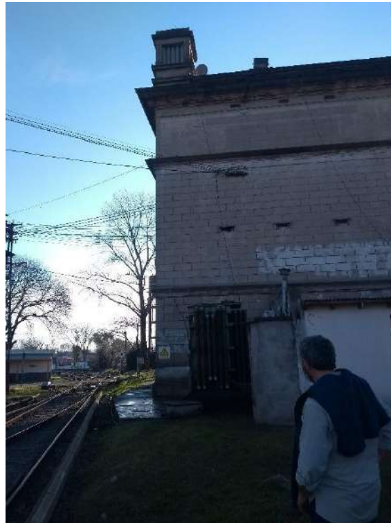
Ilustración 69 - Detalle Del Transformador Existente En La Estación Victoria
