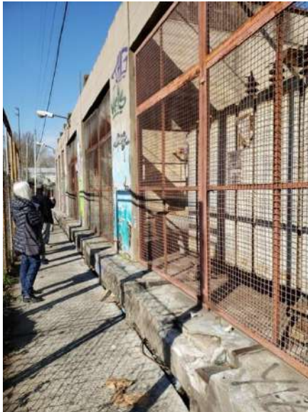
Instalaciones SER Núñez
