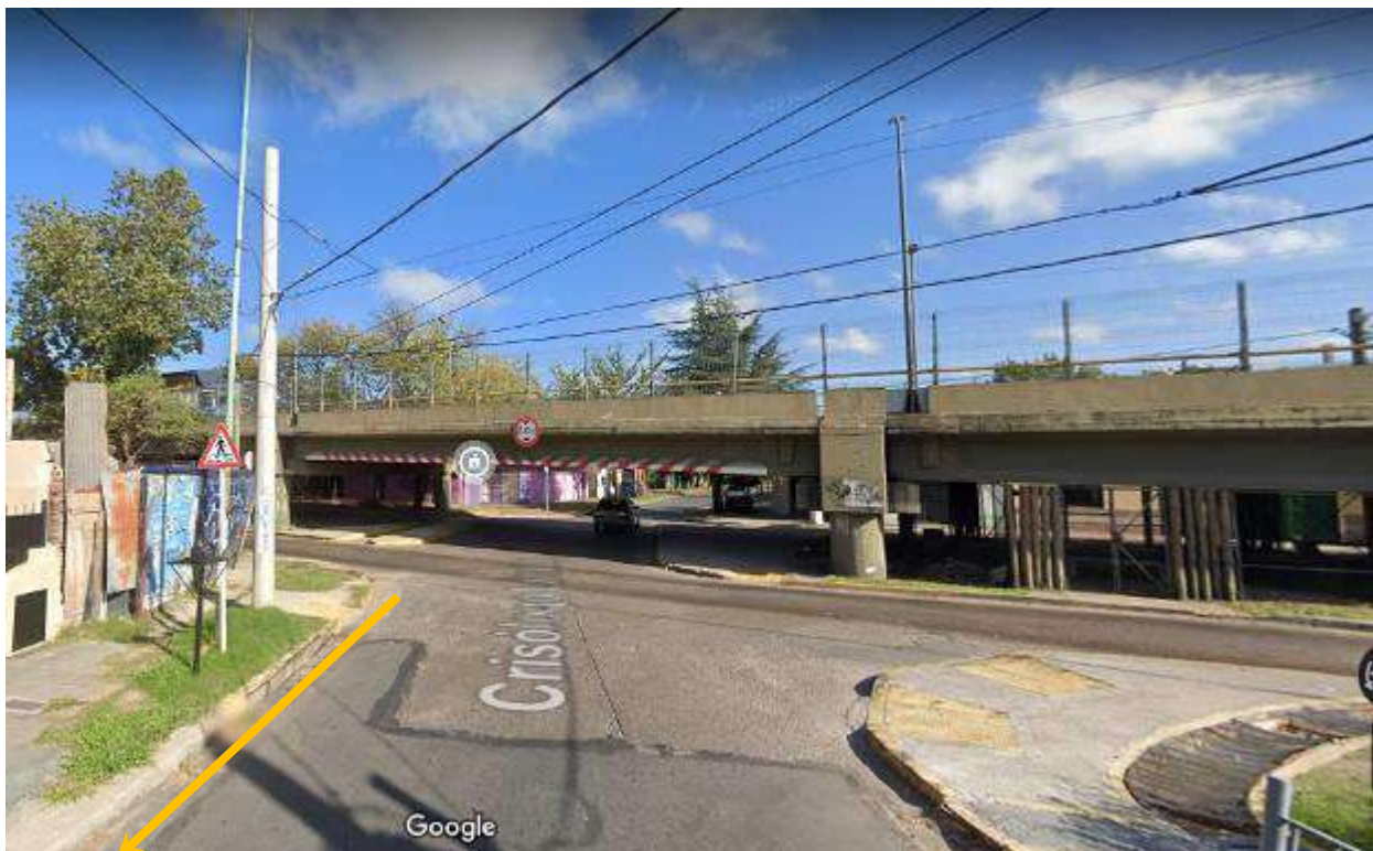
Foto 4.2. Vista desde la calle Crisólogo Larralde hacia Avenida de Juan Ruiz (Ruta Provincial N° 4). Se observa el paso elevado de la RP N° 4, señalética de tránsito, postes de tendido eléctrico y alumbrado público, calles asfaltadas.
