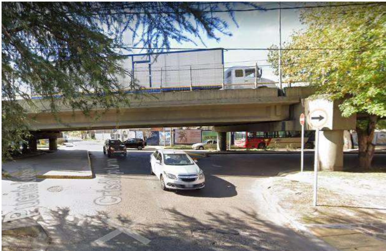
Foto 4.4. Vista desde intersección de la Avenida de Juan Ruiz (Ruta Provincial N° 4) con la calle Crisólogo Larralde, hacia calle Doyhenard.
