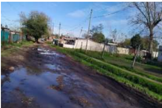
Foto 9: Anegamiento calle La Esmeralda
