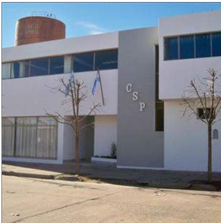
Figura 48: CSP, frente de la sede.
