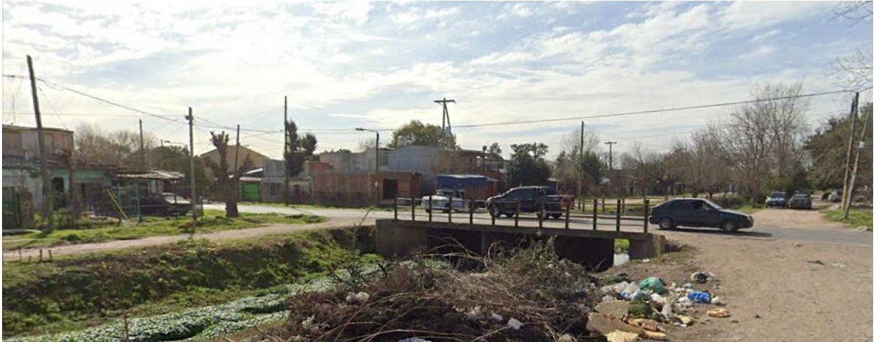
Fig. 8: Calle Arturo Capdevila y Arroyo San José.
