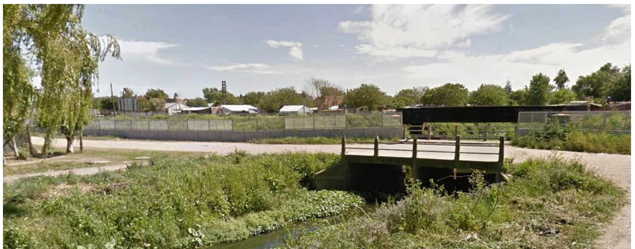
Fig. 7: Vías del Ferrocarril General Roca y Arroyo San José.
