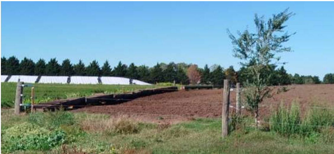
Foto n° 11: Silo de acopio de Alimento
