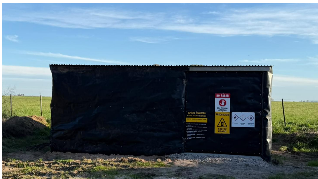
Foto 9. Sector de almacenamiento de residuos Y8. Exterior
