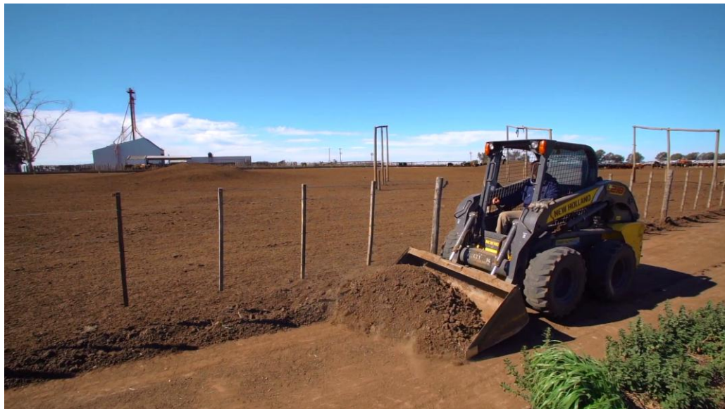
Foto 4. Pala limpiando canales
