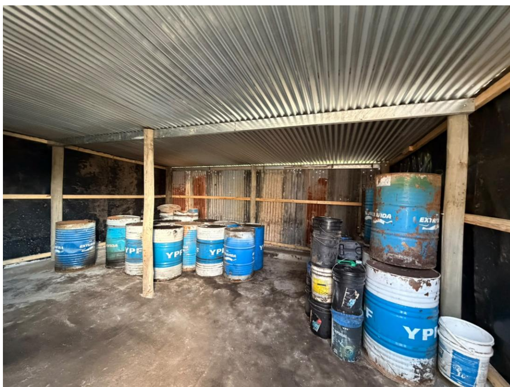
Foto 10. Sector de almacenamiento de residuos Y8. Interior
