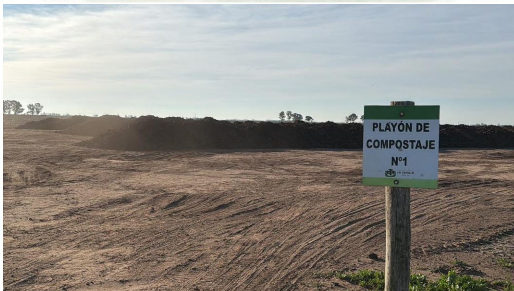
Foto 6. Playón de compostaje PdC1 impermeabilizado con piedra caliza
