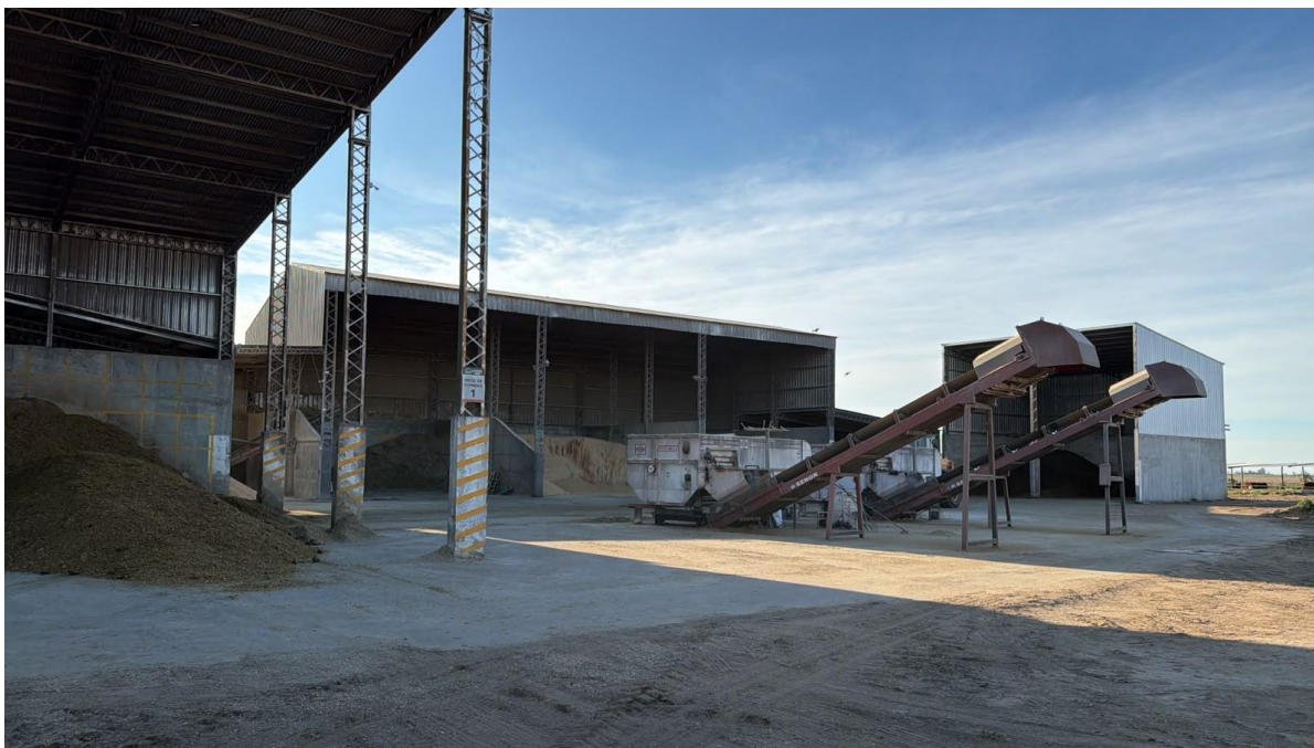
Foto 11. Patio de comidas con nueva infraestructura
