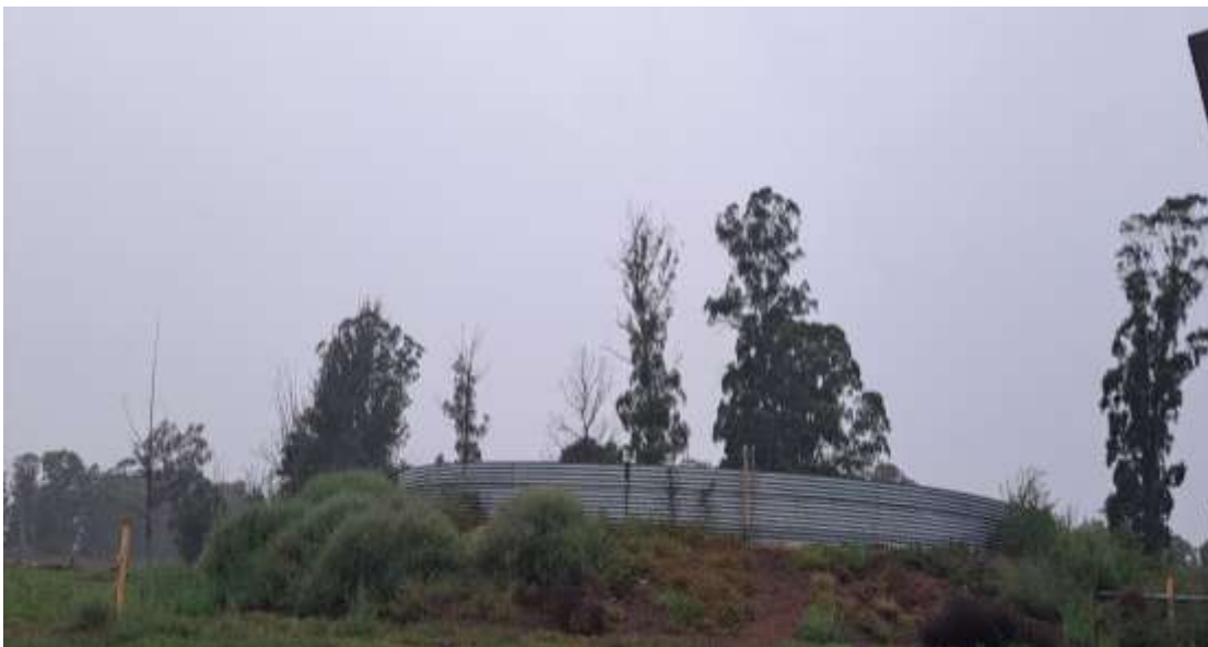
Foto nº 6: Tanque de agua
