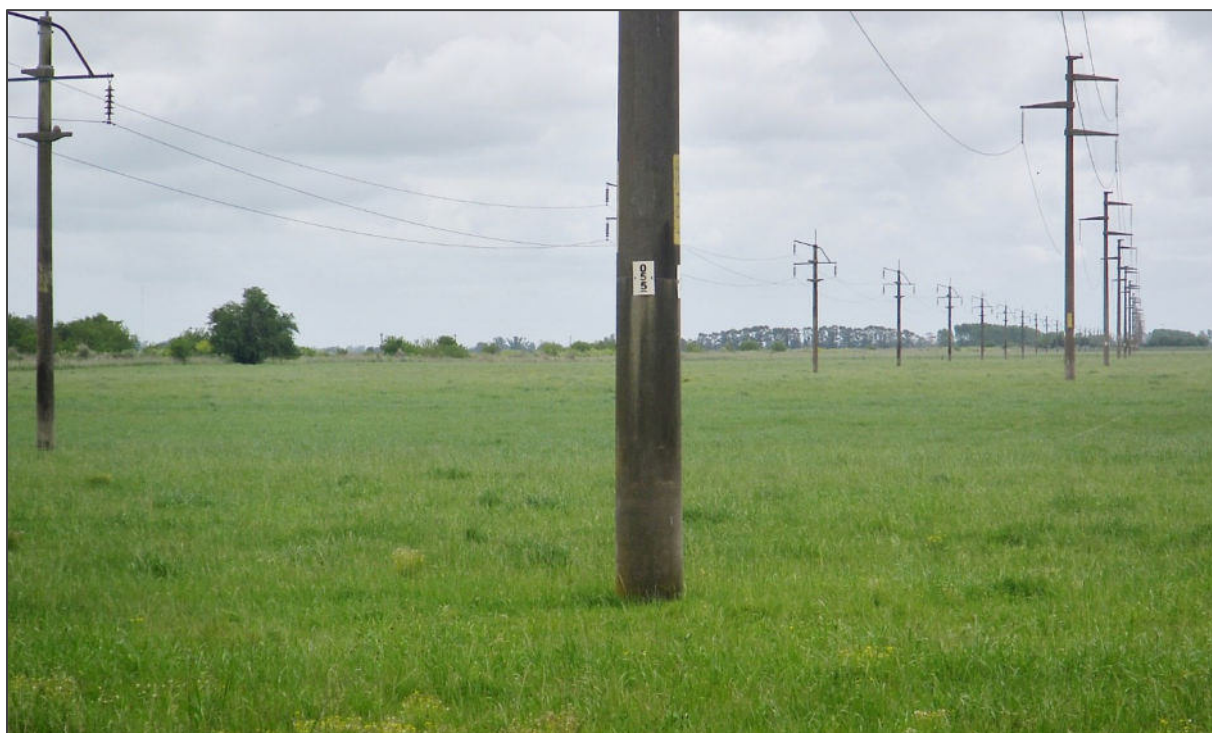
35.67732° S, 57.95148° O: P55. Vista de la implantación del poste sobre terreno natural.
