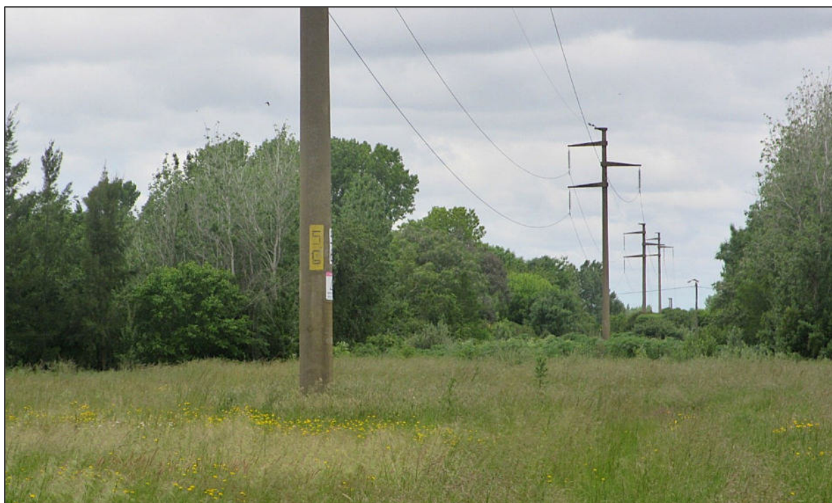
35.67882° S, 57.95173° O: P56. Vista de la implantación del poste sobre terreno natural.
