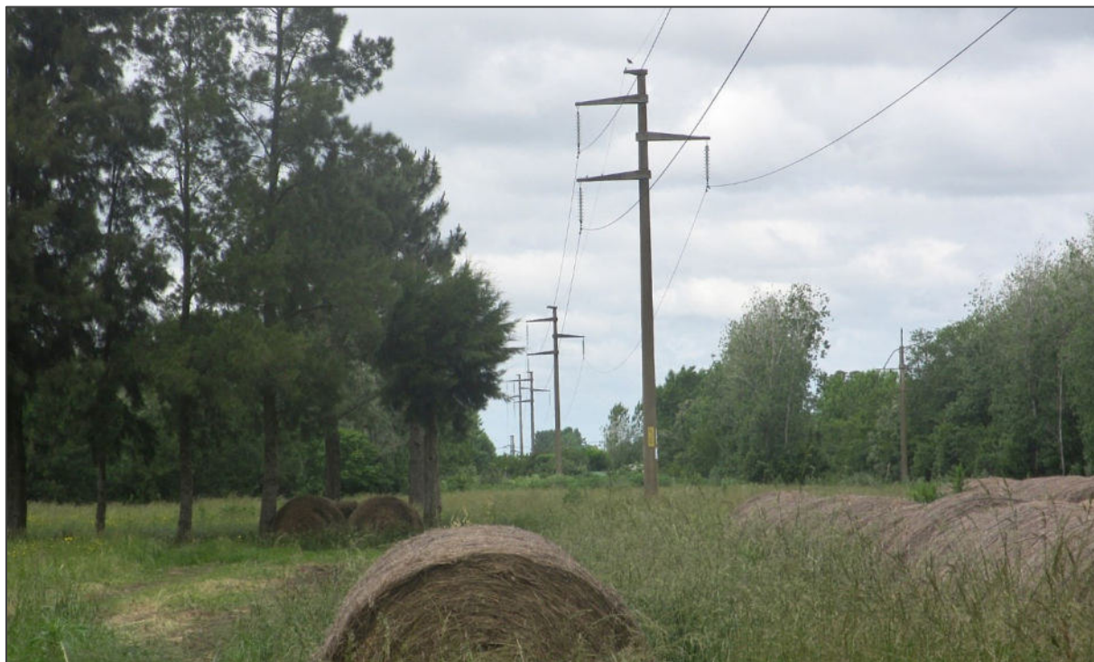
35.67810° S, 57.95145° O: P56. Traza Actual (roja) - Vista hacia el sur de la traza en campo privado Adela. Poste P56 sobre terreno natural.
