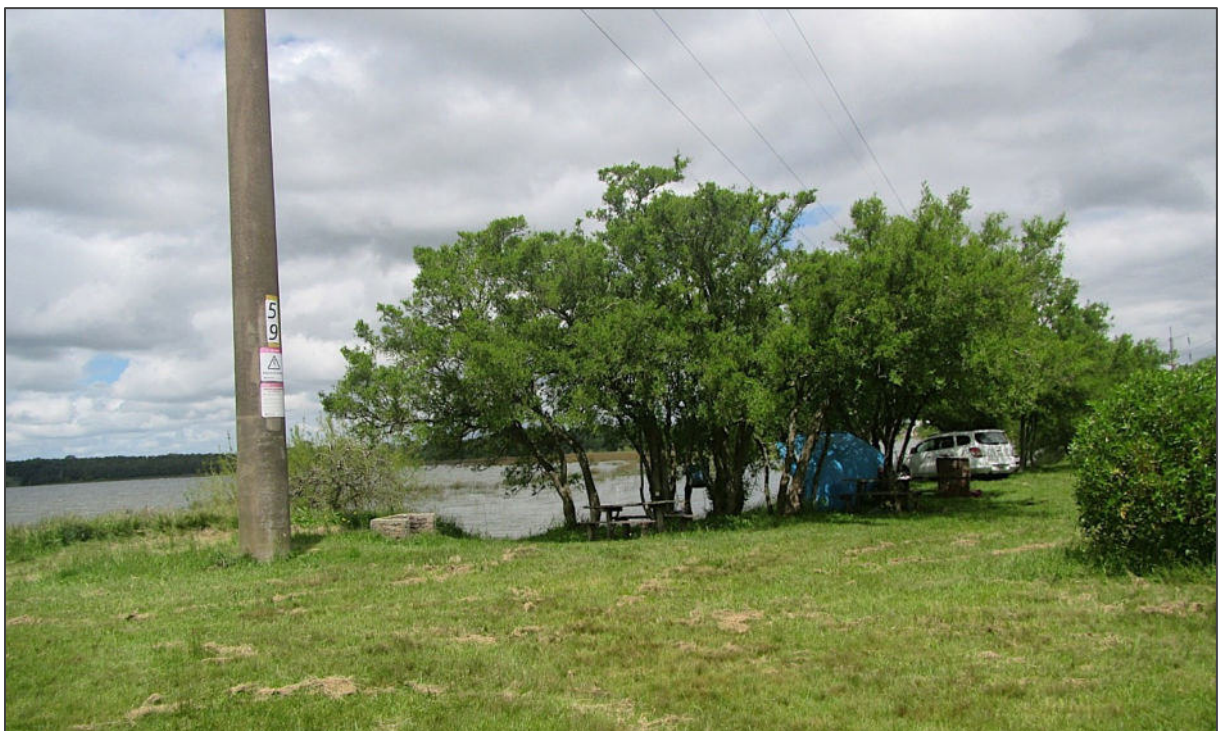
35.68534° S, 57.95225° O: P59. Vista de la implantación del poste sobre terreno natural, al lado de un sector de acampe en la orilla de la Laguna del Burro.
