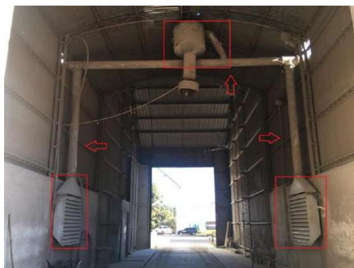
Figura 9. Sistema de captación de material particulado en rejillas.
