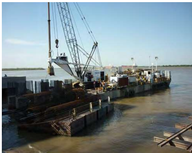
Figura 14. Imagen de referencia. Pontón principal de pilotaje y pontón auxiliar.
