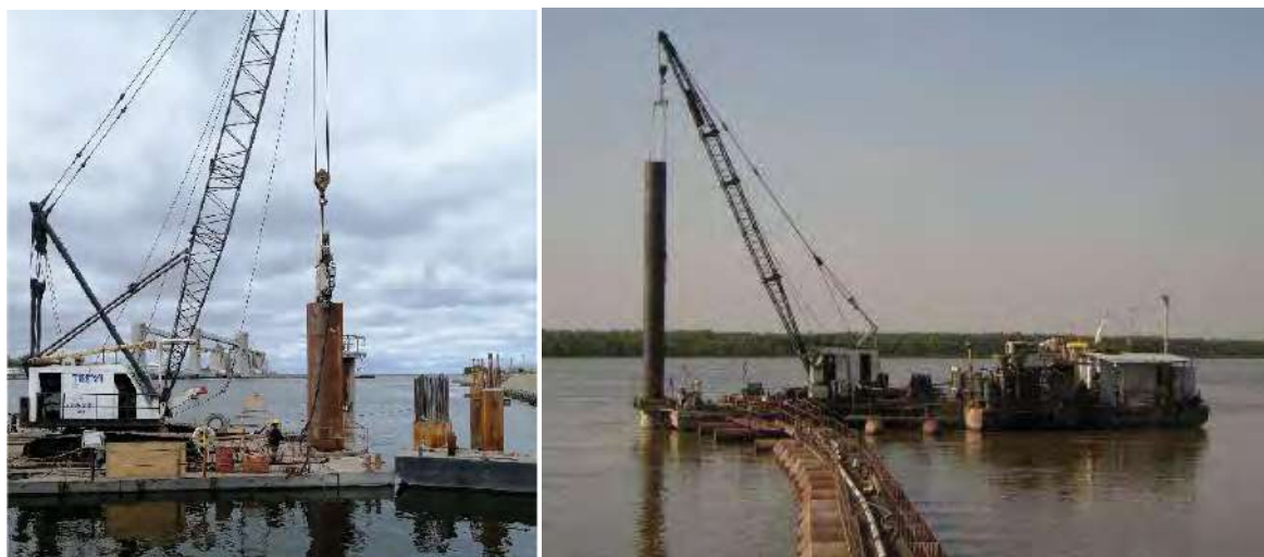
Figura 15. Imagen de referencia. Instalación de camisas metálicas para pilotes.
