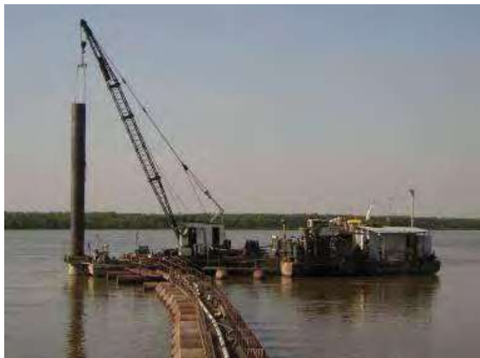
Figura 13. Imagen de referencia. Pasarela flotante de trabajo que permite acceso peatonal a los frentes.
