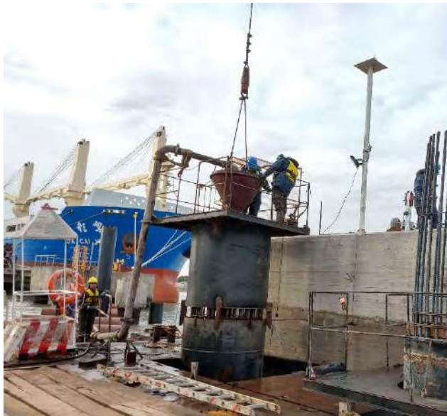
Figura 18. Hormigonado del Pilote se observa plataforma y embudo. Esta fotografía solo se muestra a modo de referencia y no corresponde al muelle en estudio.
