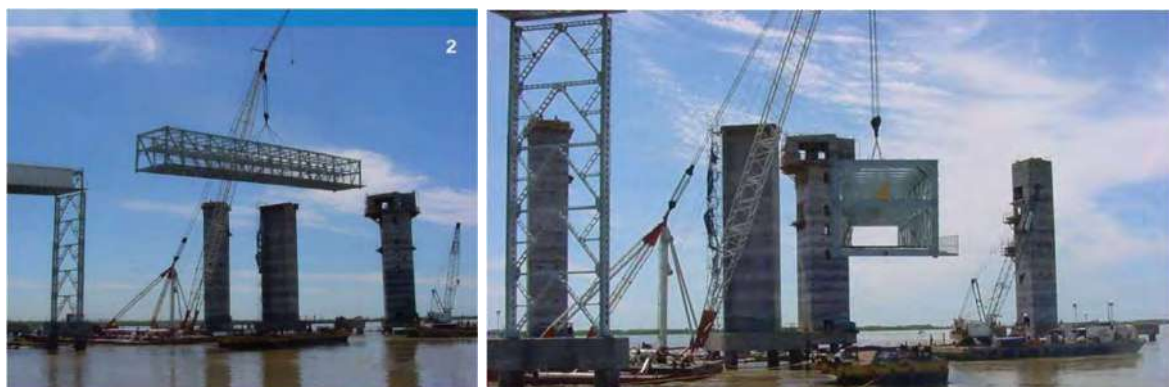
Figura 21. Imagen de referencia. Montaje de estructuras metálicas en agua.
