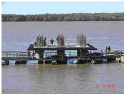
Figura 19. Imagen de referencia. Entramado de vigas de perfiles laminados para sostén de losa de fondo y encofrados.
