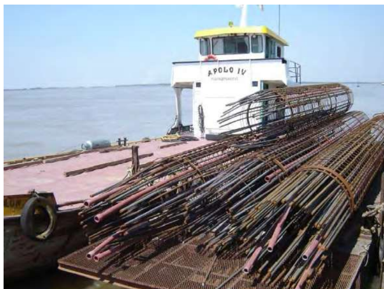
Figura 12. Imagen de referencia. Transporte de jaulas de armadura para pilotes y tramos de camisas metálicas en pontón auxiliar.
