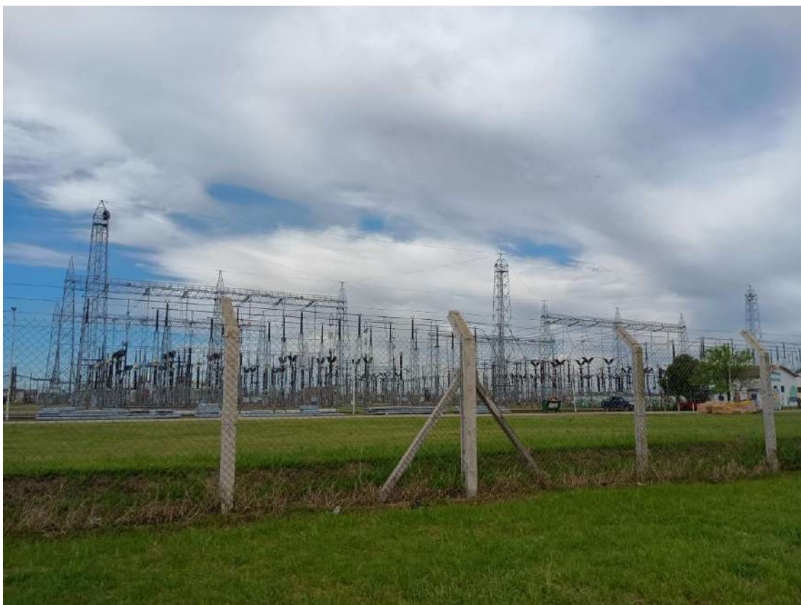
Fotografía 5 – Vista exterior ET
