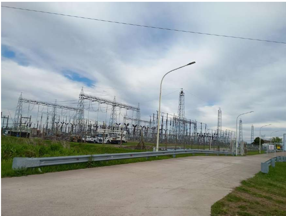
Fotografía 4 – Vista exterior ET
