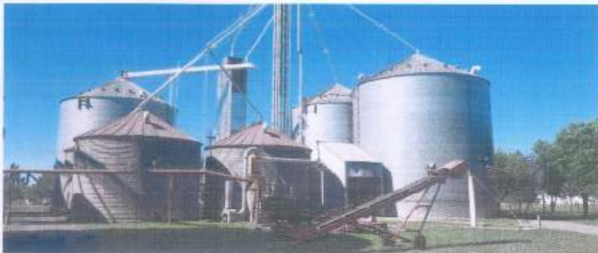
Silos de Almacenamiento de Granos
