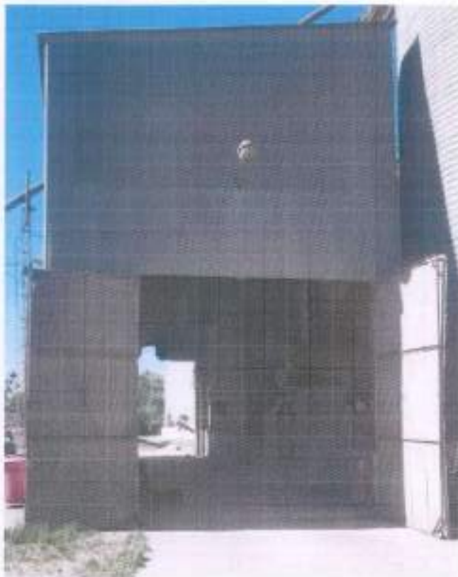
Zona de Carga y Descarga de Camiones N° 1
