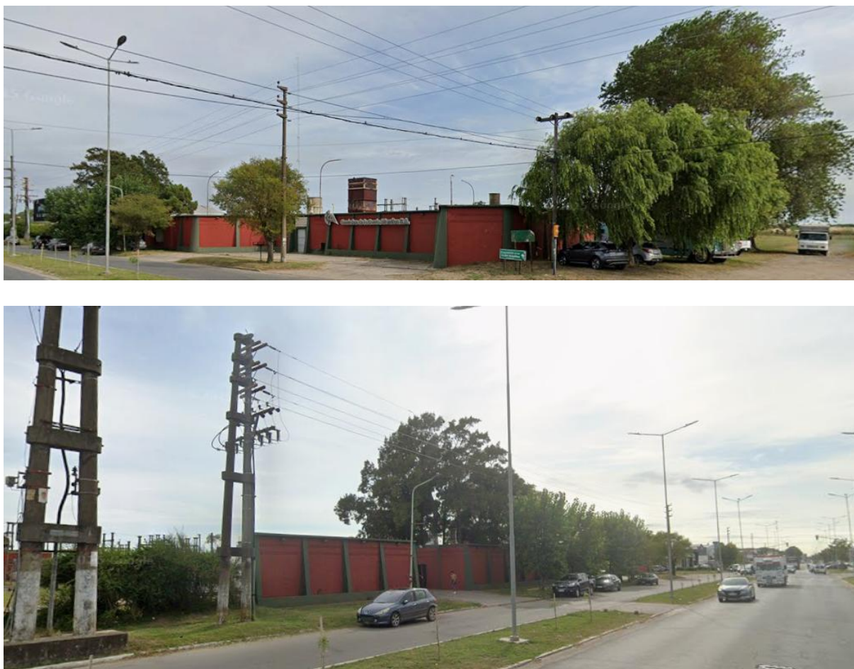
Figura 1.3 – Vistas panorámicas de la CT MdA desde la avenida.
