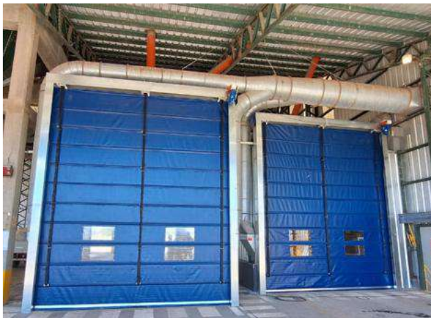
Cerramiento de cortinas y sistema de aspiración en zona de descarga de camiones
