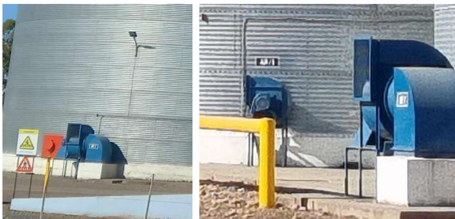
Sistema de aireación de granos
