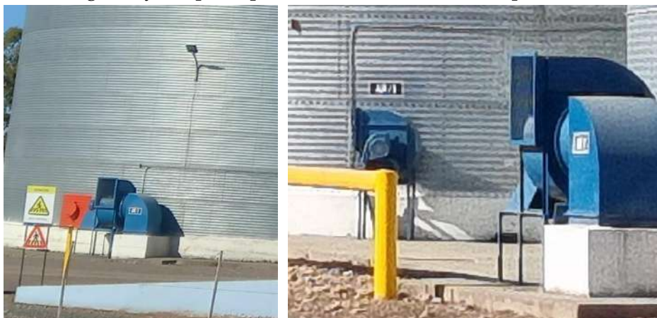
Sistema de aireación de granos
