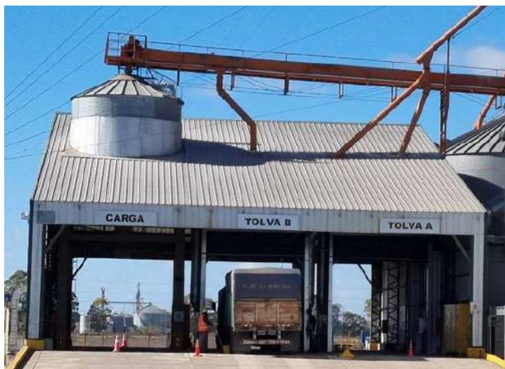
Vista de silo pulmón en zona de carga
