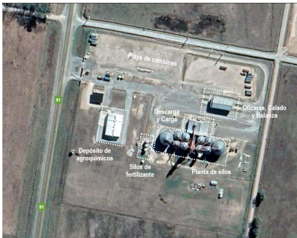
Vista aérea del establecimiento e identificación de los principales sectores operativos
