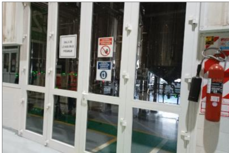
Figura: Vista de una de las salas de levaduras presente.
