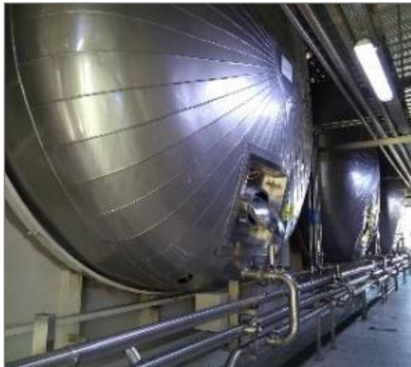
Figura: Vista de los tanques horizontales de fermentación.
