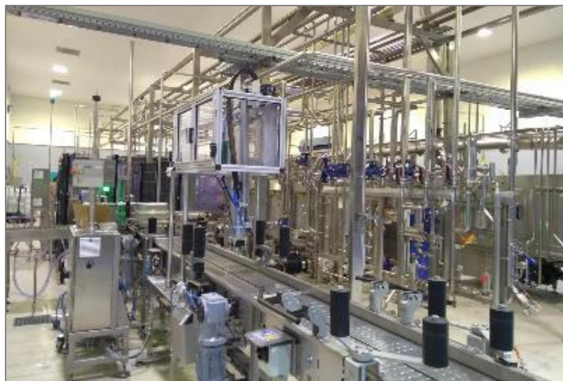
Figura: Vistas de la nueva línea de barriles.
