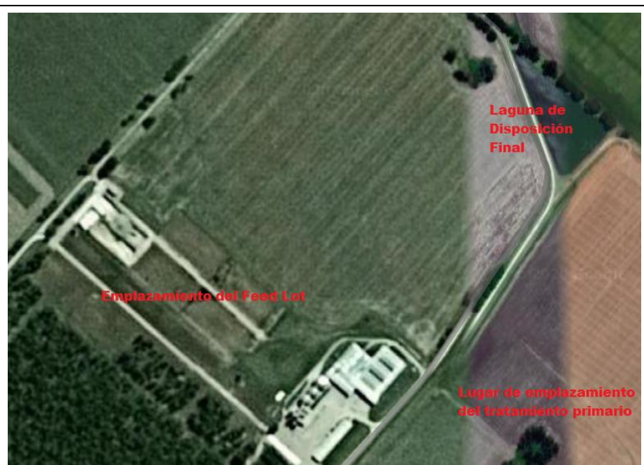
Vista del sector de construcción de captación y disposición final de líquidos
