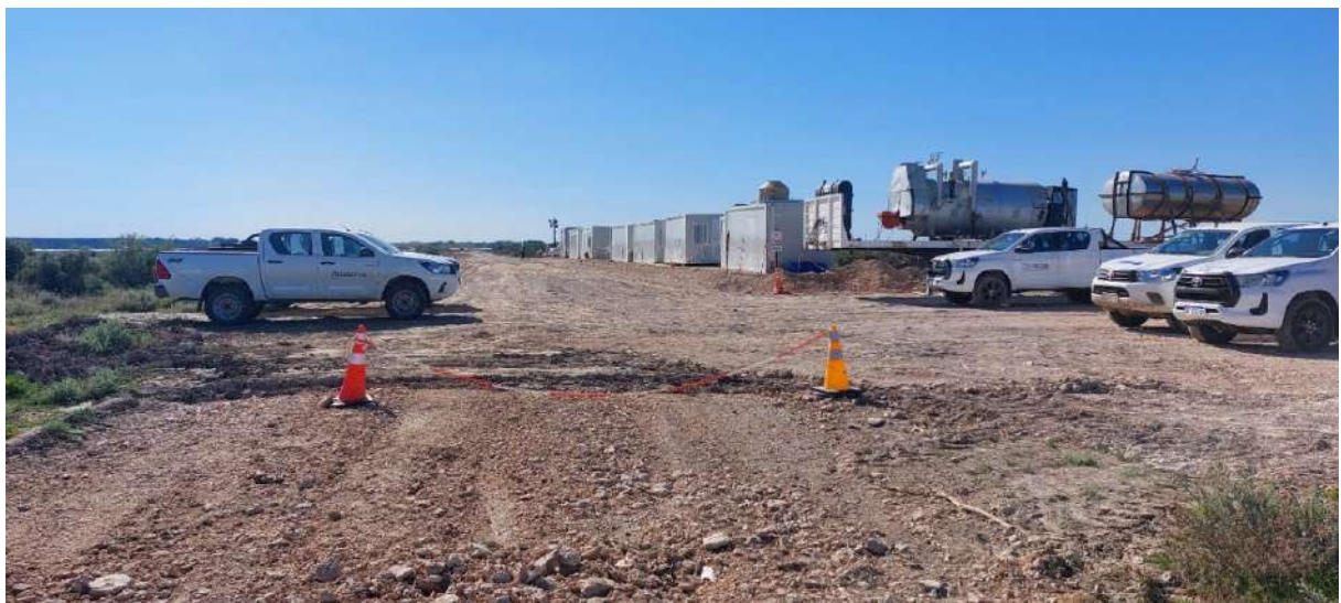
Foto N° 10: Obrador y estacionamiento existentes en el sitio (coordenadas 38^{\circ}44'33.47''S - 62^{\circ}35'37.83''O ) ubicado a 8 m. al sureste de distancia del ducto regular
