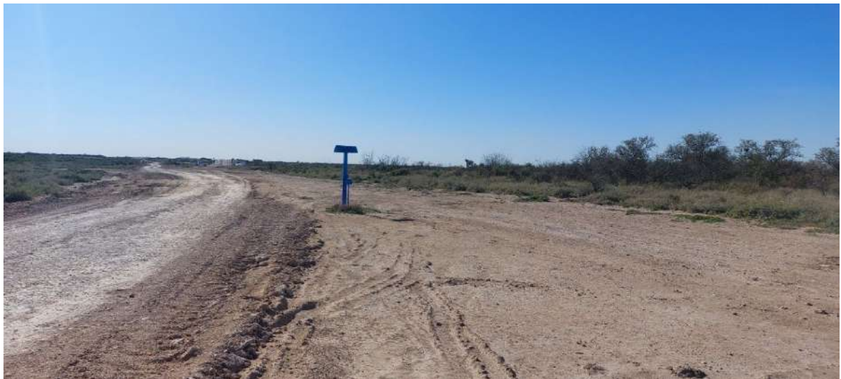
Foto N° 9: Camino de acceso a calle de servidumbre existente de Oldelval ubicado a 15 m al noreste del ducto regular ( 38^{\circ}44'37.34''S - 62^{\circ}35'48.15''O ). Aquí puede verse señalización de una de las líneas de Oldelval presentes en la zona. La materialización de la cañería se realizaría sobre parte de vegetación que se observa de la derecha de la imagen.
