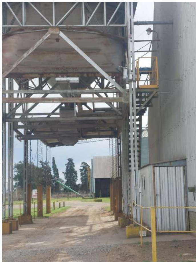
Ilustración 22 - Carga de camiones.
