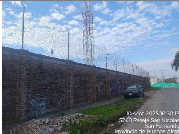
Foto 3.1-17 Pasaje San Nicolás 5300. Recorrido de línea de Media Tensión, llegada a Planta Transformadora EDENOR. Vista SE-NO.
