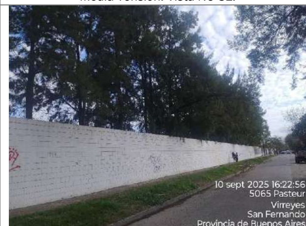
Foto 3.1-12. Calle Pasteur 5200 Recorrido de línea de Media Tensión. Vista NO-SE.
