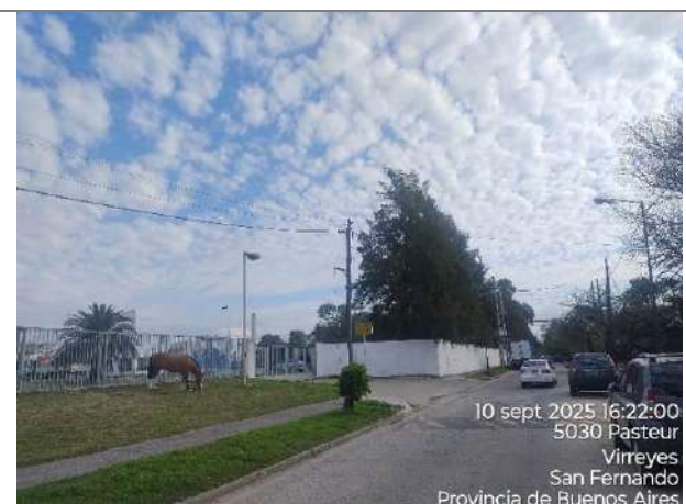
Foto 3.1-11. Calle Pasteur 5100 Recorrido de línea de Media Tensión. Vista NO-SE.
