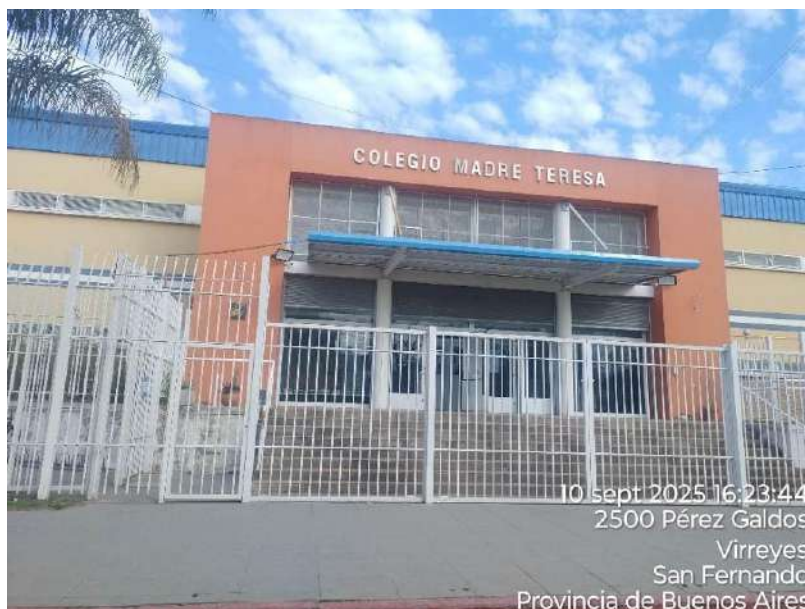
Foto 3.5.7-1. Colegio Madre Teresa a 400 m al sudoeste del predio de interés, sobre la línea de Media Tensión
