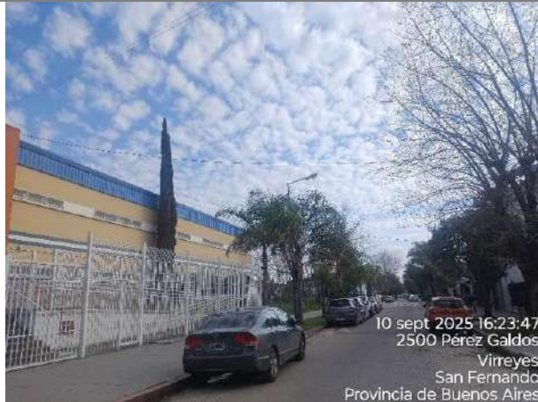
Foto 3.1-13 Calle Pasteur 5300. Recorrido de línea de Media Tensión pasa por el frente de Colegio Madre Teresa. Vista NO-SE.
