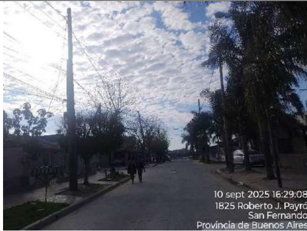
Foto 3.1-15 Calle Roberto Payró 1800. Recorrido de línea de Media Tensión en barrio residencial. Vista Sur-Norte.
