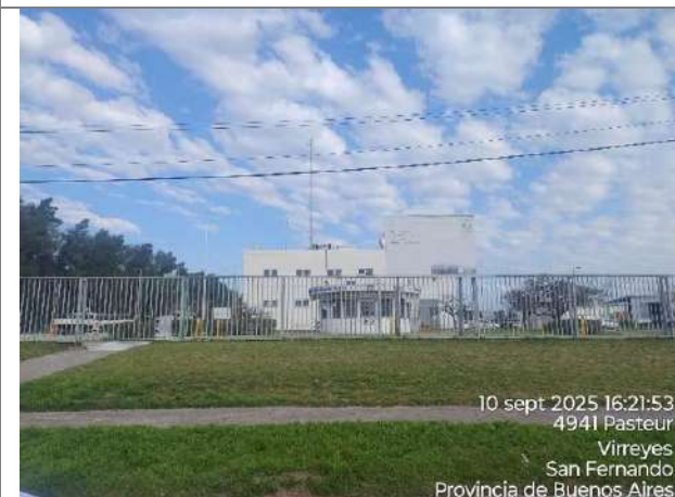
Foto 3.1-10. Planta Depuradora Norte para tratamiento de aguas sobre calle Pasteur 5300, adyacente al predio de emplazamiento del proyecto. Recorrido de línea de Media Tensión. Vista NO-SE.
