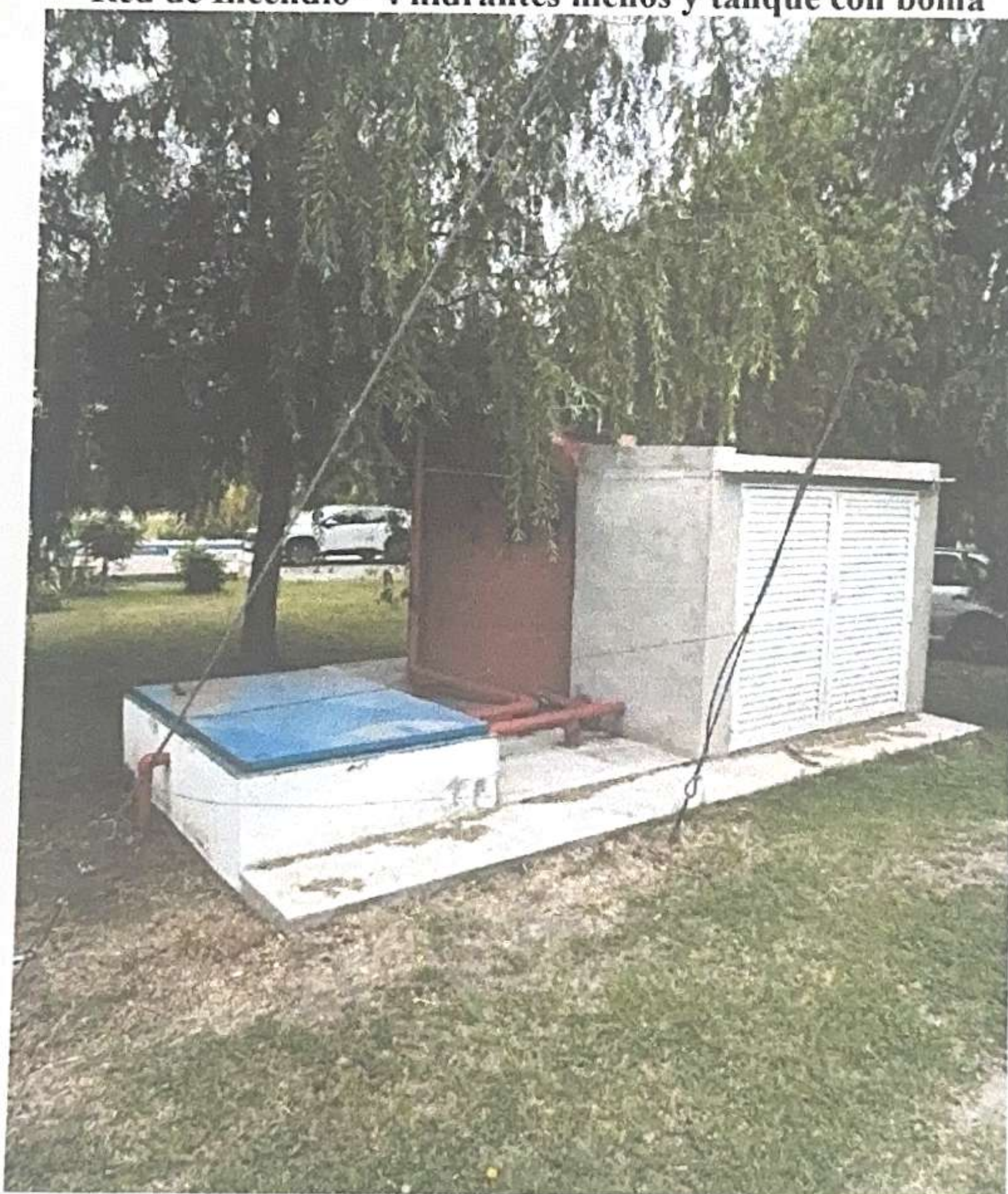
Red de Incendio - 4 hidrantes nichos y tanque con boma
