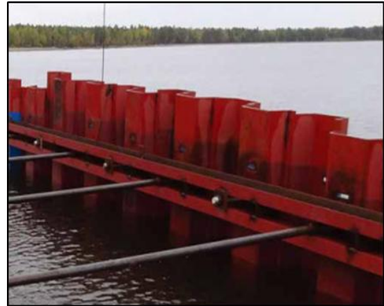
Figura 7: Ejemplos colocación de tablestacado para la conformación de muelles y equipo empleado.
