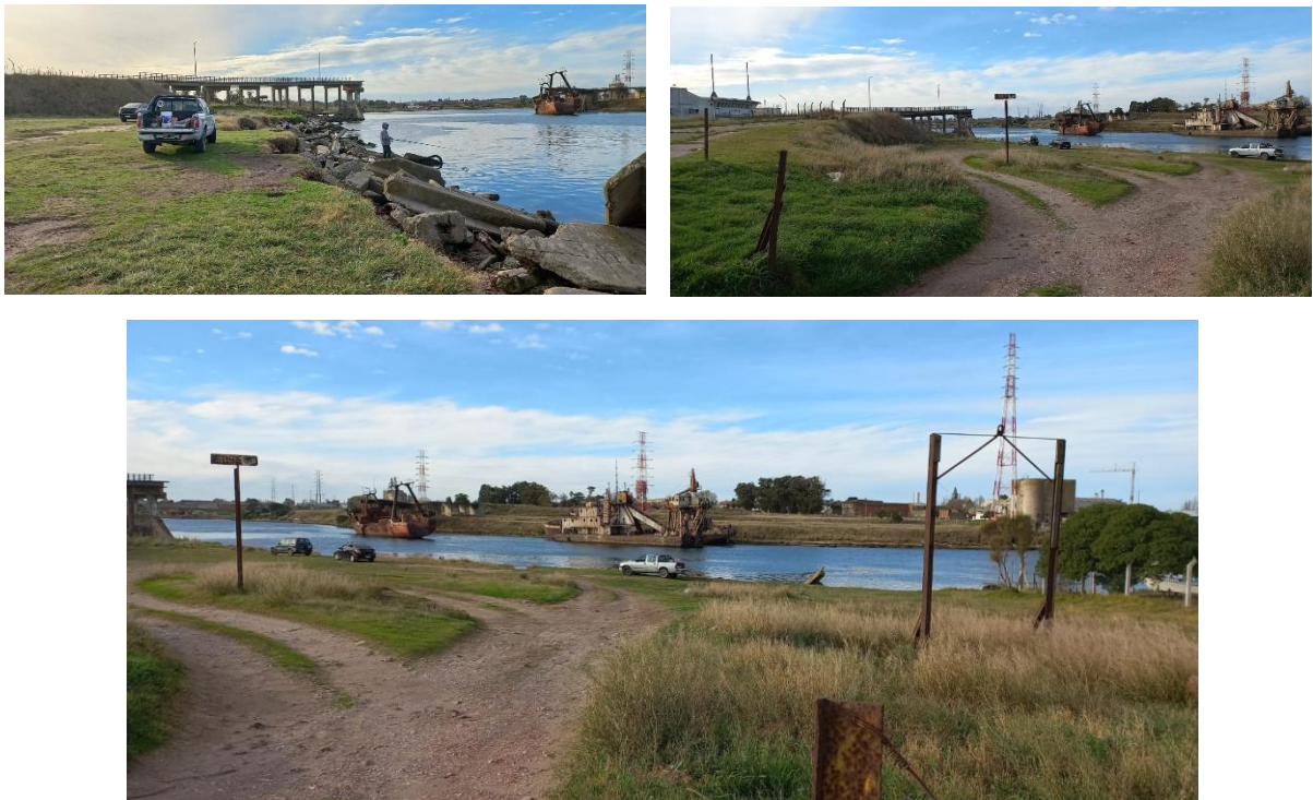
Figura 10: Predio Bahía de los pescadores. Noviembre 2025. Figura de autor
