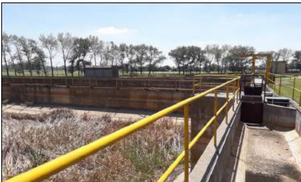
Piletas de Aireación. Fuente: Fotografía Propia.
