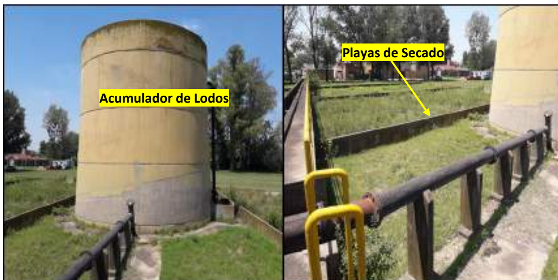
Acumulador de Lodos. Fuente: Fotografía Propia
