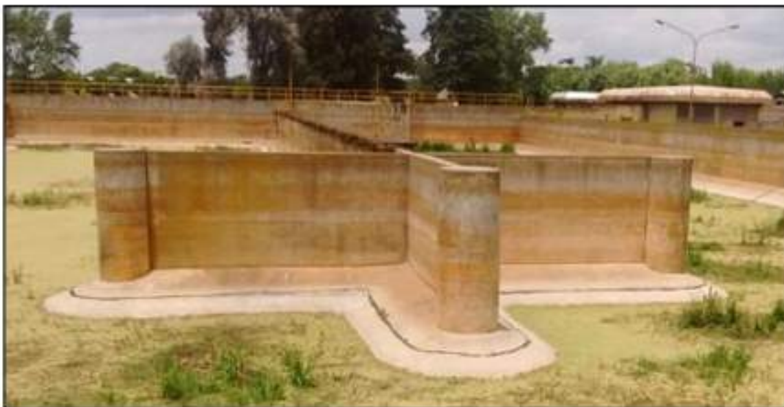
Piletas de Aireación. Fuente: Fotografía Propia.2017
