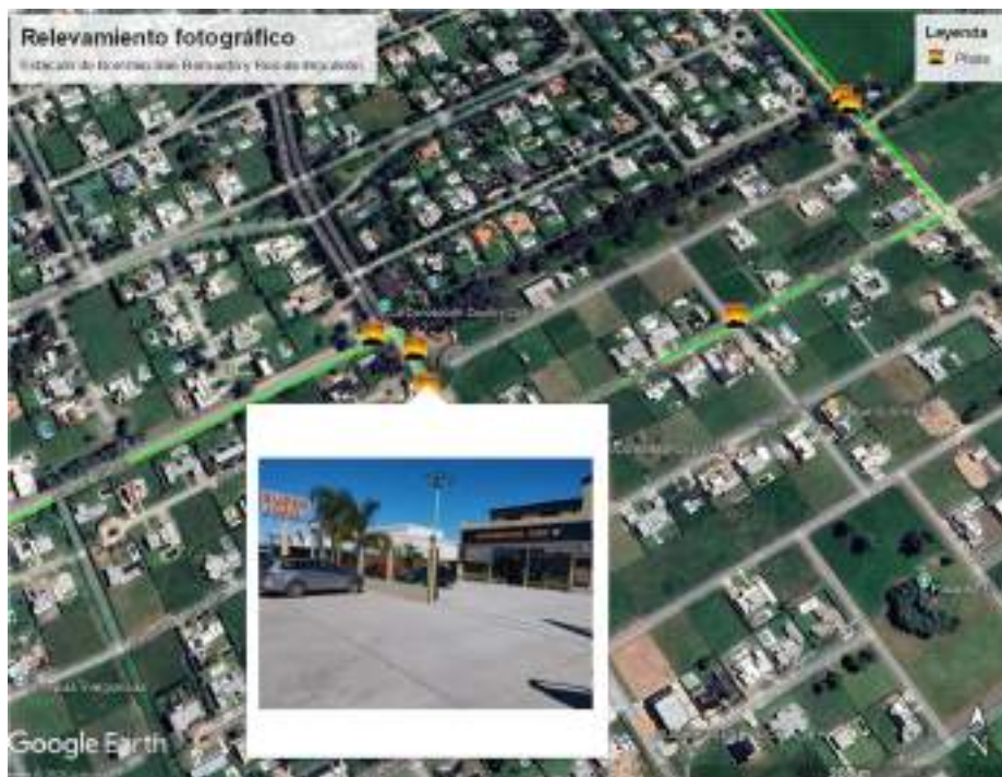
Figura 36 - Vista de supermercado sobre calle Alfonsina Storni
