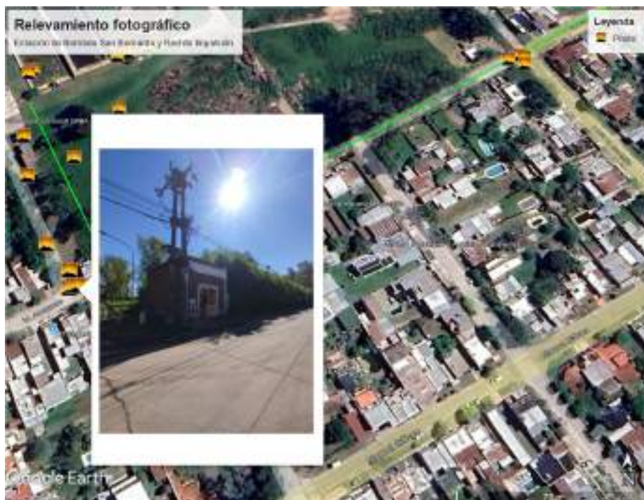
Figura 21 - Vista de Estación transformadora en frente del predio
