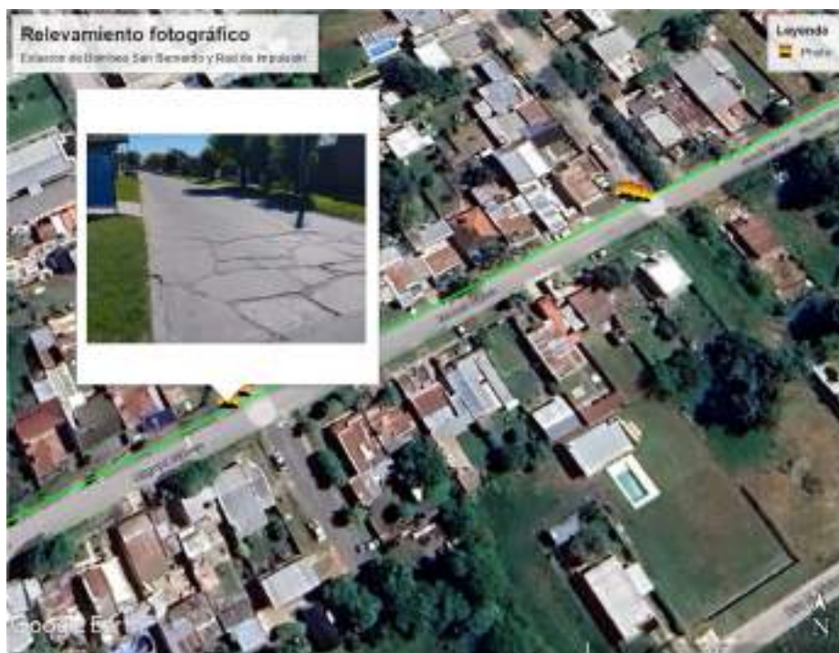
Figura 26 - Vista de calle Patricios donde se puede observar parada de colectivo
