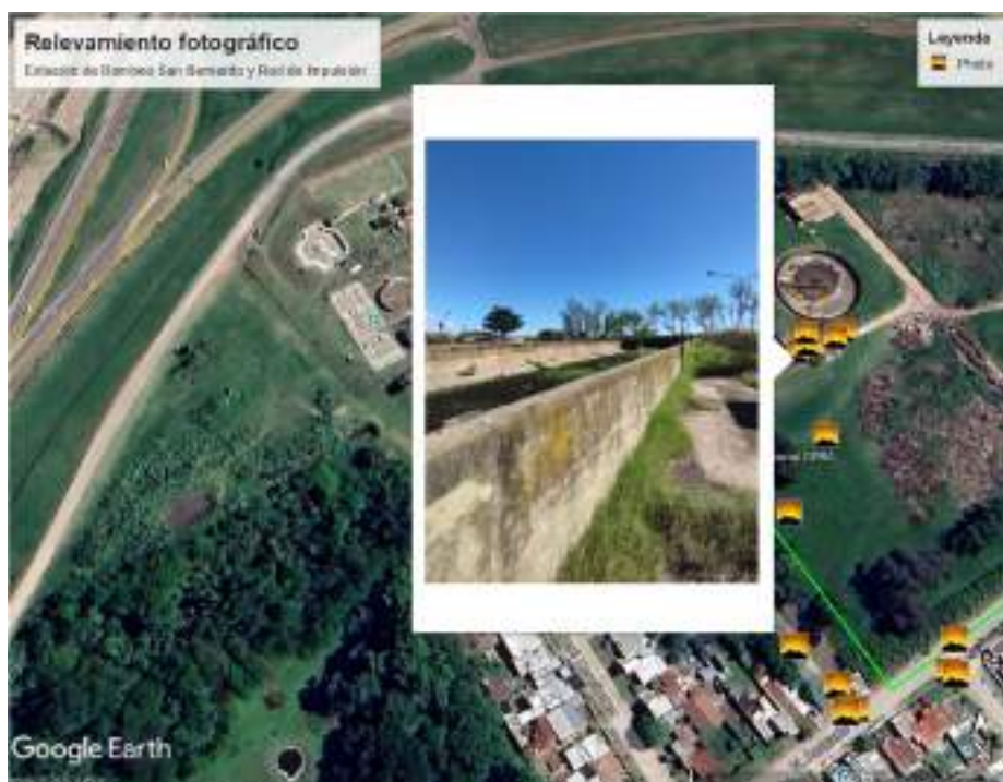
Figura 17 - Vista de reactor aeróbico a demoler
