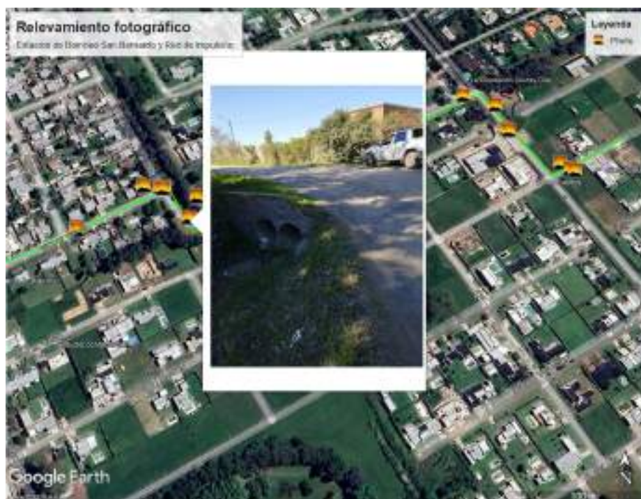
Figura 33 - Alcantarilla cruce Calle Galvez
