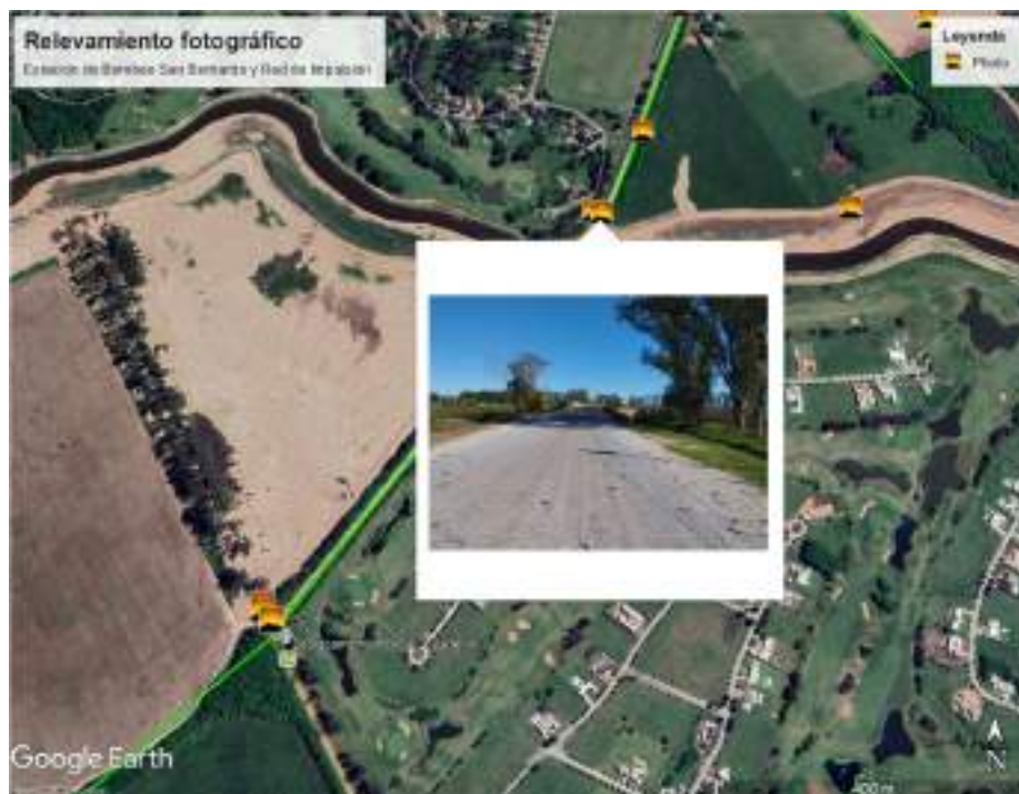
Figura 42 - Vista de acceso a puente
