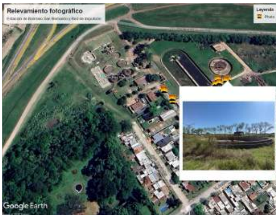
Figura 16 - Vista de sedimentador a demoler
