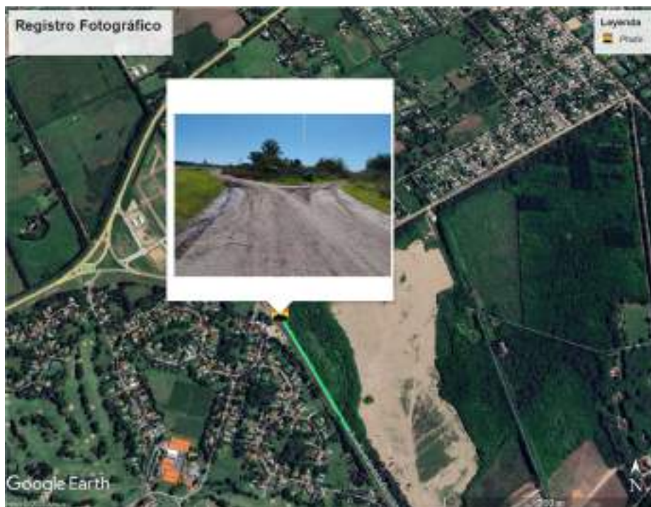
Figura 45 - Vista de acceso hacia calle Juan de Dios Filiberto
