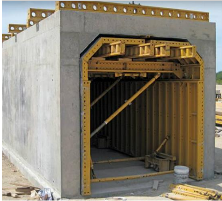
Figura 29: Ejemplo de encofrado deslizable para la construcción de ductos
