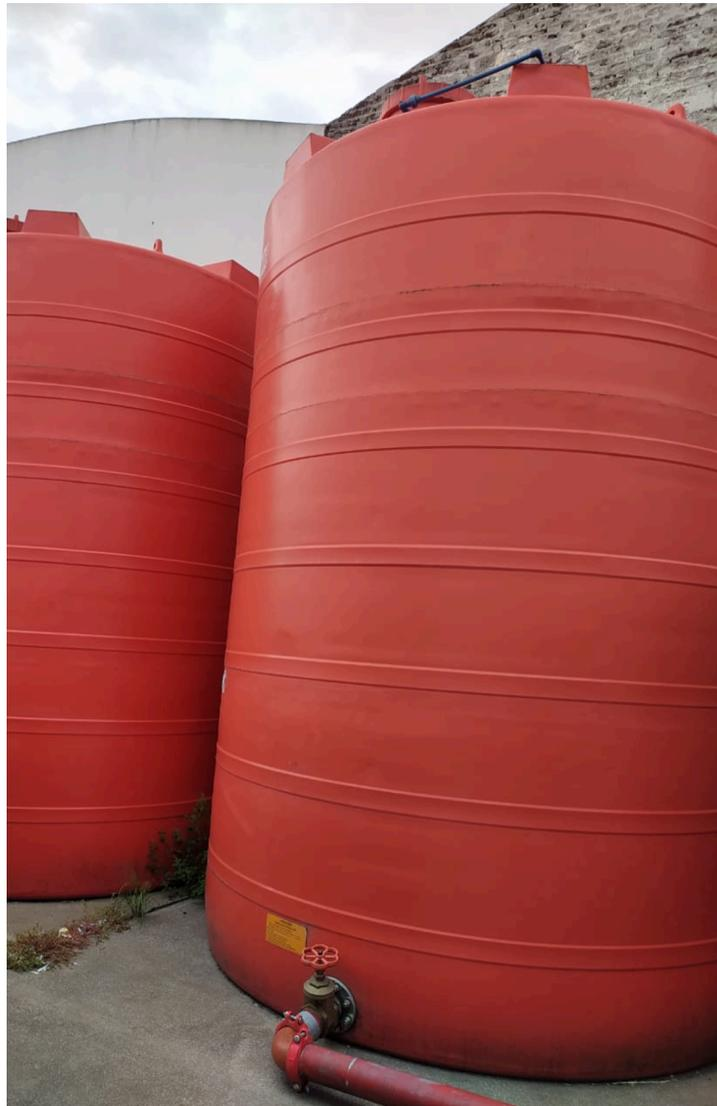
*Imagen N°7: Tanques de alimentación de la red de incendio*
