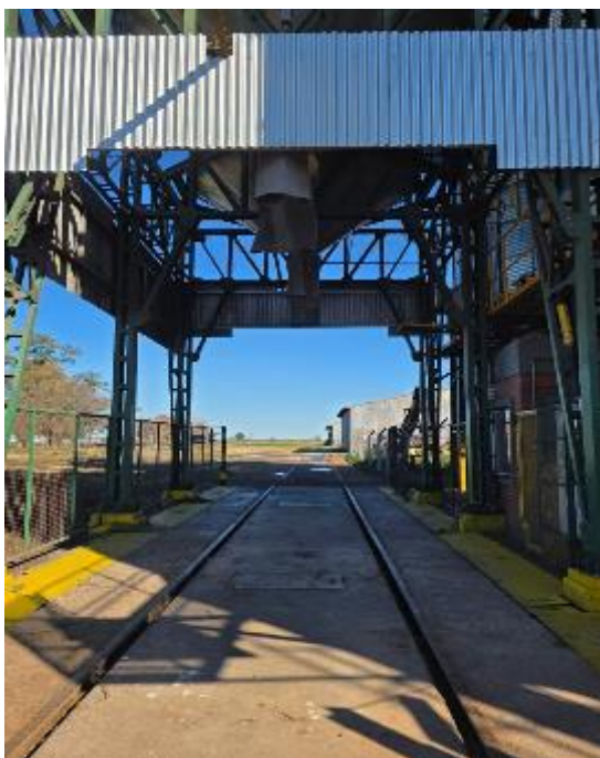
Imagen 17. Cerramiento de sector de carga de vagones.
