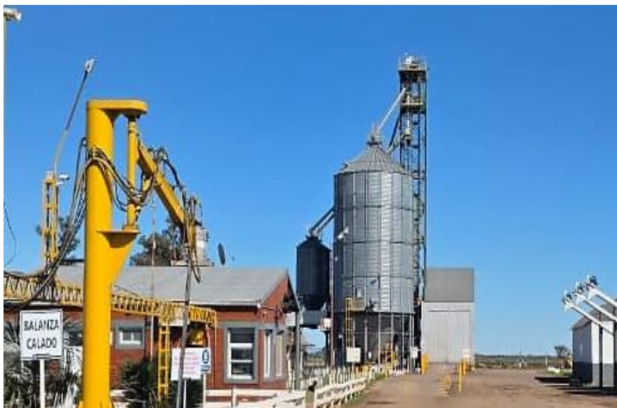
Imagen 9. Silos de almacenamiento.
