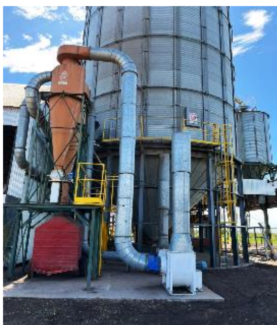
Imagen 19. Viste sistema de aspiración en norias.
