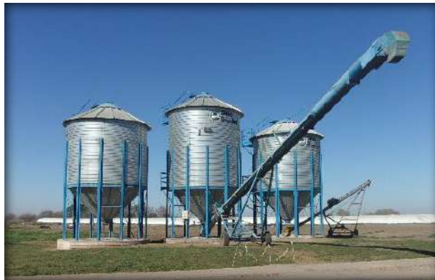
Vista de silos de fertilizantes.
