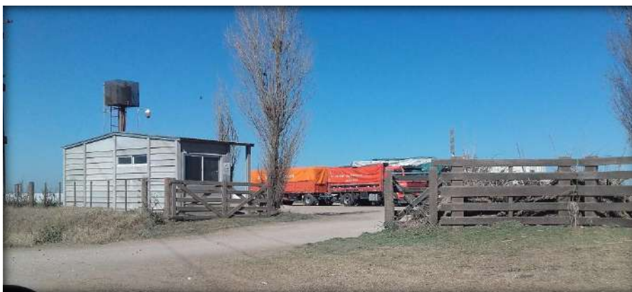
Vista de ingreso a playa de estacionamiento y sanitarios correspondientes.
