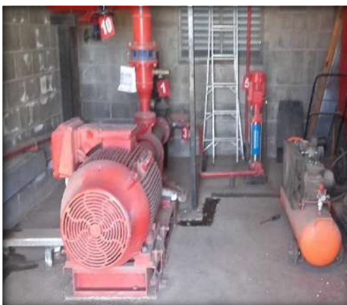
Vista de red hidrantes instalados en planta, reserva de incendio, bombas y sala de bombas.
