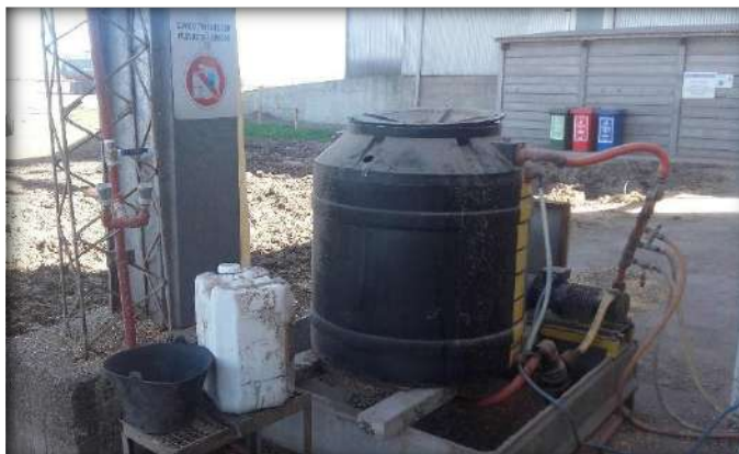
Sector de dilución de fitosanitizantes y triple lavado.
