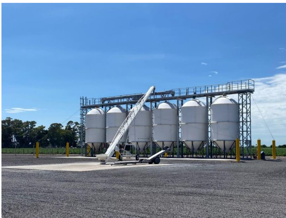
Silos para almacenaje de fertilizantes sólidos.
