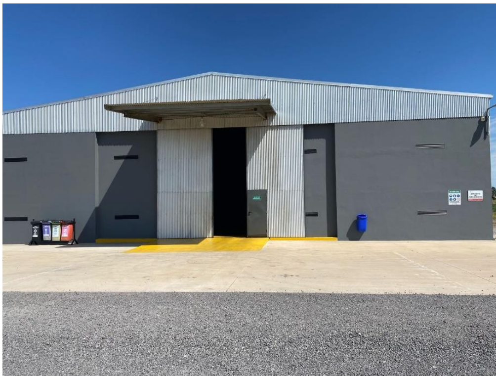
Depósito de Productos Fitosanitarios.
