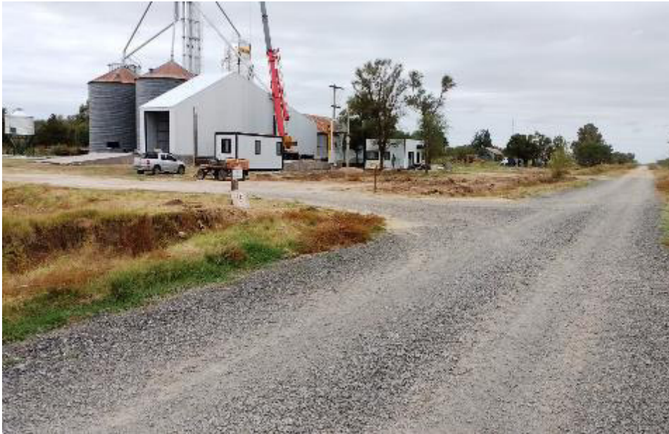
Imagen 04. Área de ingreso de camiones.
