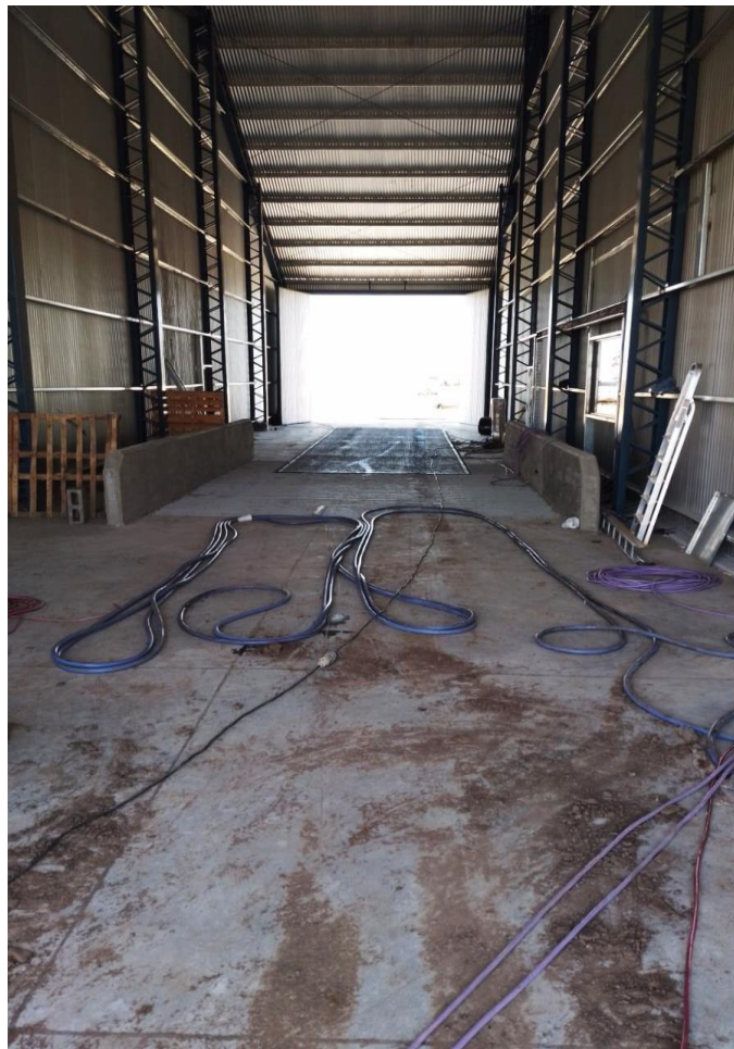
Imagen 10. Detalle de zona de descarga de granos.
