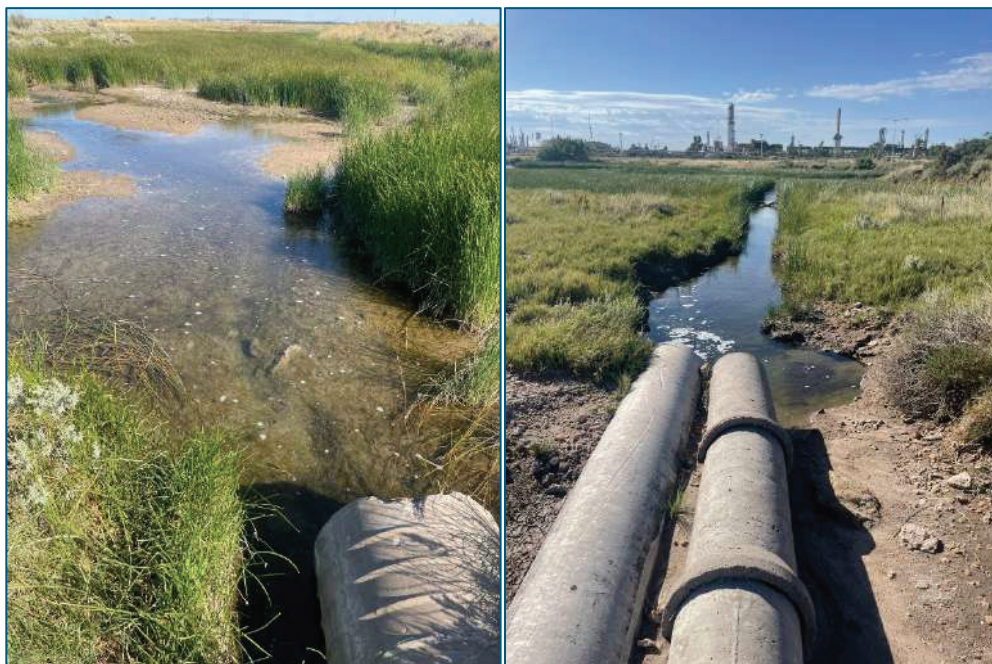
Imagen N° 18: Tubería de concreto que cruza por debajo del camino.
