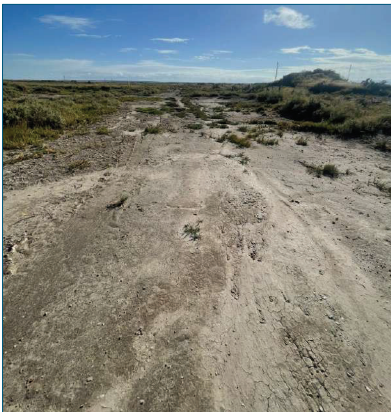
Imagen N° 15: Imagen de la traza del ducto de MEGA hacia el noreste.
