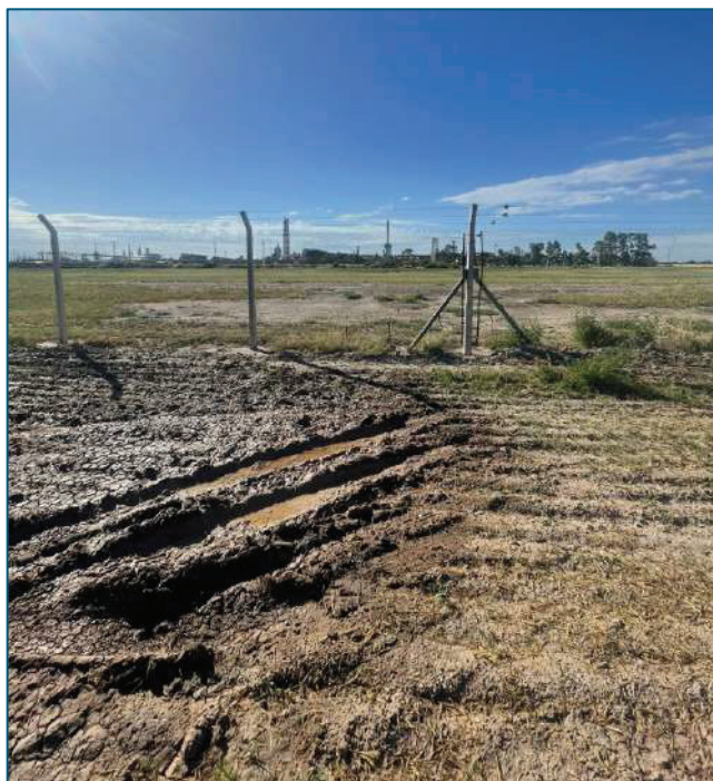
Imagen N° 5: Inicio de la traza del ducto fuera de los límites de planta.
