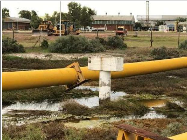
**Foto 3.1-1.** Vista del desplazamiento de las cañerías aéreas respecto de sus soportes.
