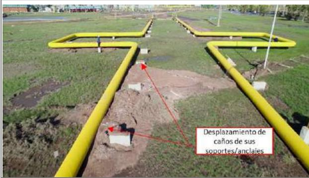
Foto 3.1-5. Vista del desplazamiento de las cañerías respecto de sus soportes.
