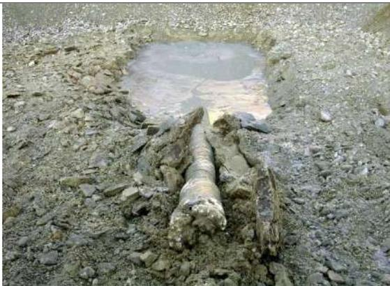
Foto 2-12. Salida de la perforación piloto.
