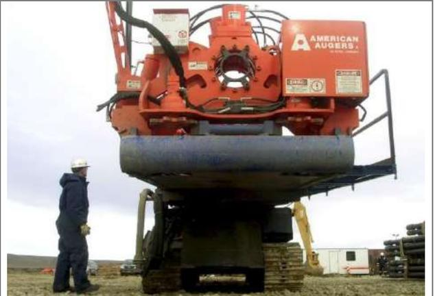
**Foto 2-3.** Instalación de máquina de perforación.
