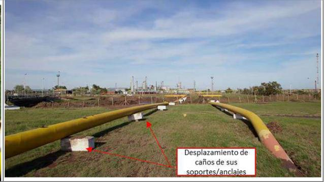
Foto 3.1-6. Vista del desplazamiento de las cañerías respecto de sus soportes.
