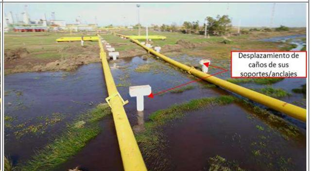
**Foto 3.1-4.** Vista del desplazamiento de las cañerías respecto de sus soportes en el cruce de Arroyo Saladillo.
