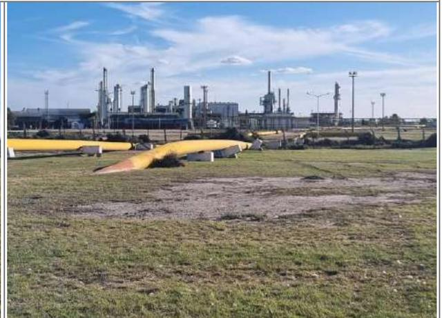
Foto 3.1-9. Vista de tramos aéreos de los gasoductos GLSM y NEUBA I sobre soportes temporales
