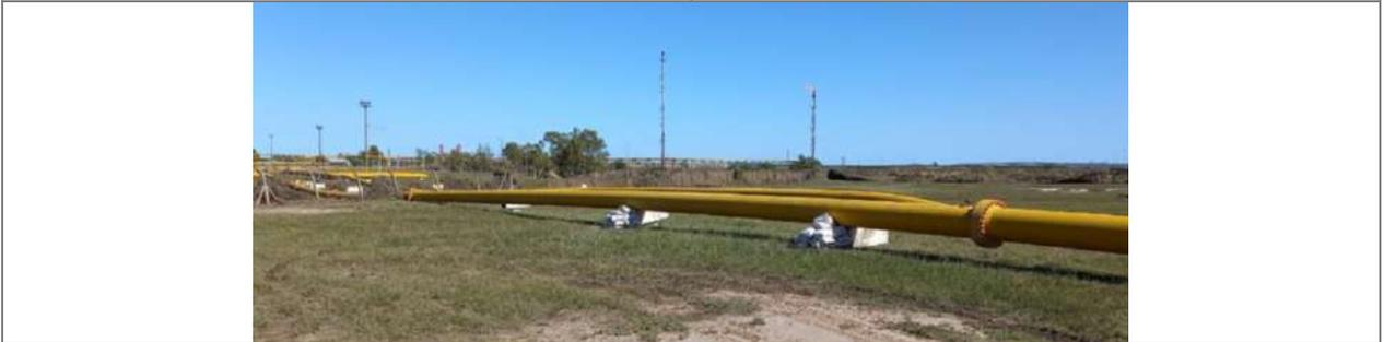
Foto 3.1-7. Soportes temporales colocados bajo los tramos aéreos a reemplazar.
