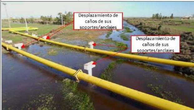
**Foto 3.1-3.** Vista del desplazamiento de las cañerías respecto de sus soportes en el cruce de Arroyo Saladillo.
