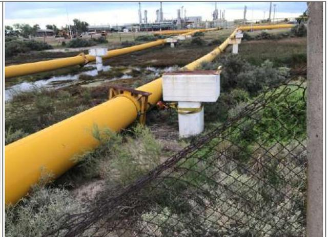
**Foto 3.1-2.** Vista del desplazamiento de las cañerías aéreas respecto de sus soportes.
