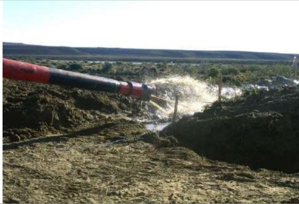
Foto 2-8. Inyección de lodos de perforación.
